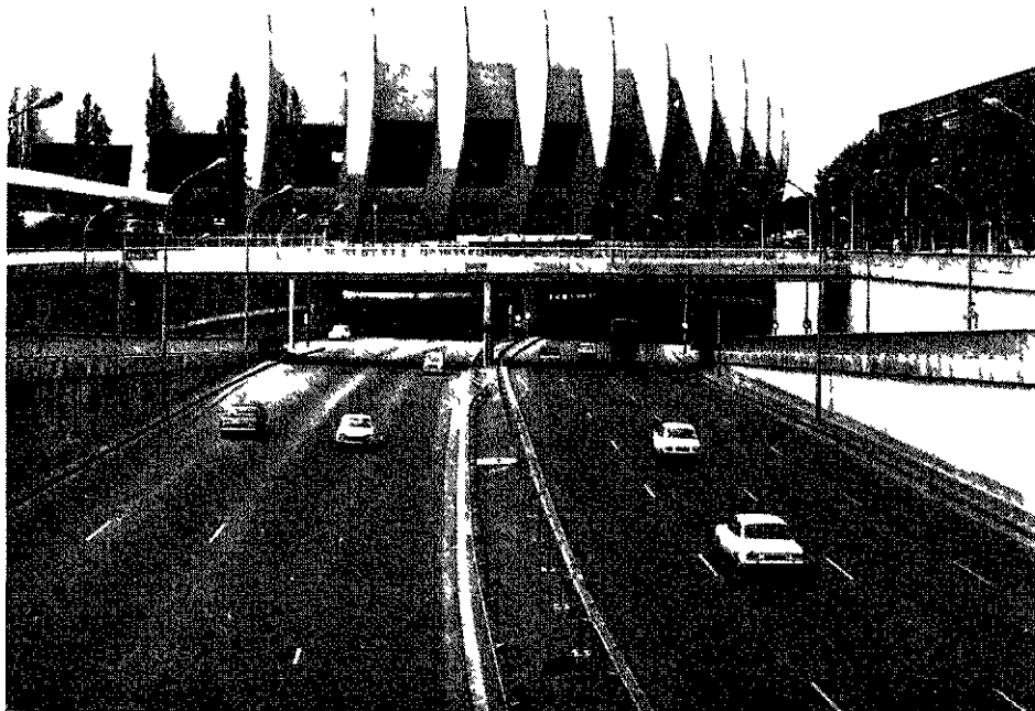
Grand périphérique Nord - Echangeur Porte de Saint-Cloud. Passage sous le parc des Princes
