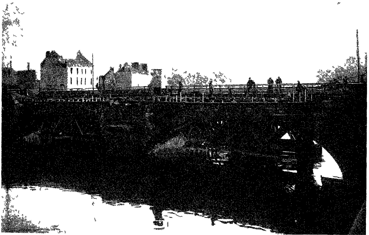
LE PONT NEUF SOUS LA R N 12 A LAVAL
