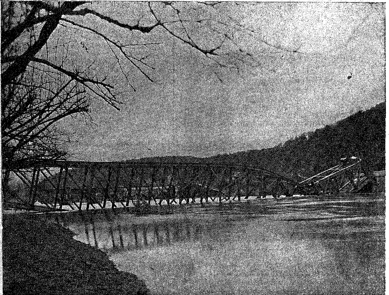
Le pont de Liverdun avant relevage
