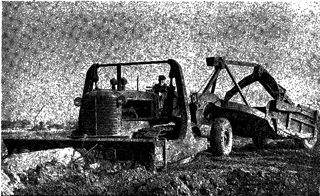
Fig. 1. — Un scraper tiré par un tracteur équipé en bull dozer, prêté par les Autorités Américaines
