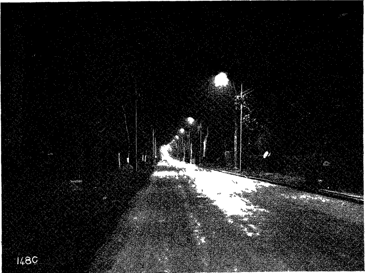
Fig. 3. — Eclairage par lampes à vapeur de sodium.
