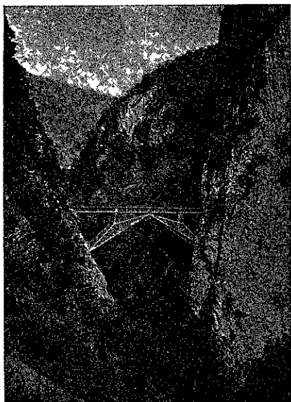
Viaduc du Faux Namti (Indo-Chine)
