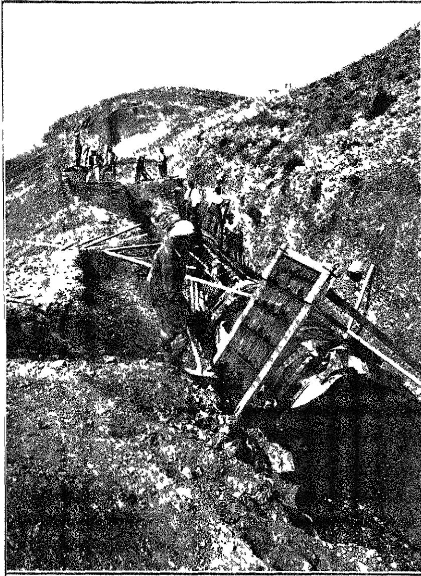
La canalisation en construction
