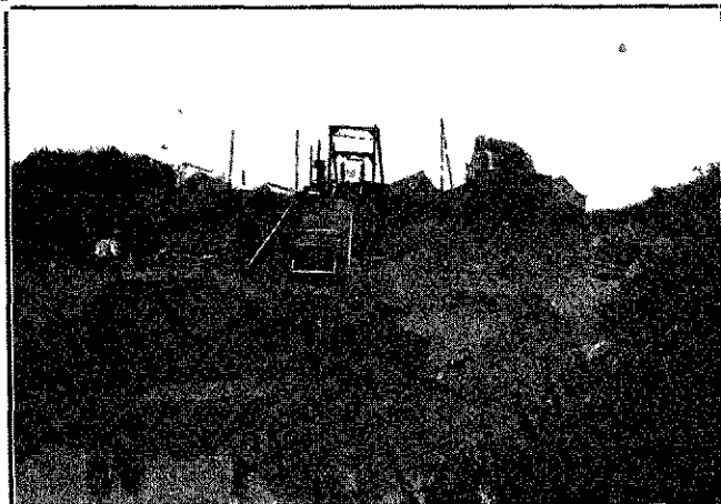
Exploitation d'une sablière par treuil PIC AB1 moteur à essence de 22 chevaux.
