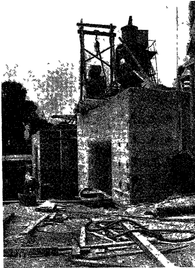
Le fonçage du caisson de la tête amont continue (juillet 1930)
