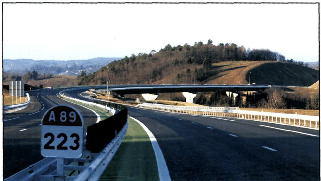
Viaduc de Chadon - A89
