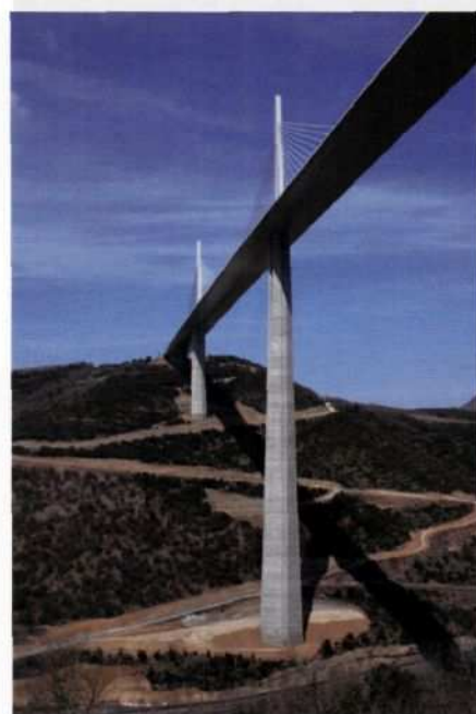
Versant nord : après aménagement, avant végétalisation
