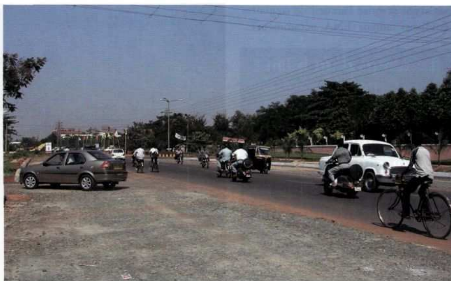
Élargissement de chaussée en zone périurbaine à Bhubaneswar (Orissa)
