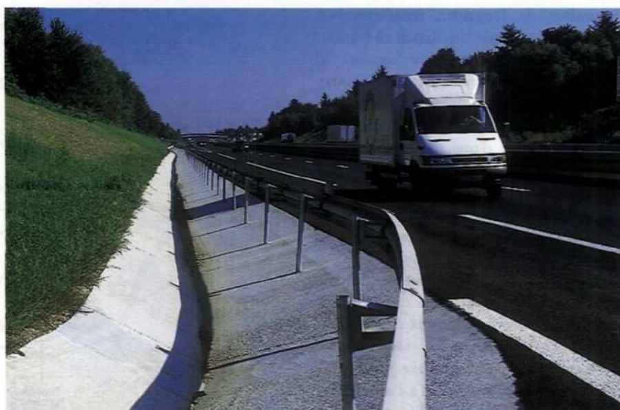
Les ouvrages hydrauliques en béton permettent de respecter la loi sur l'eau et son obligation de recueillir puis de filtrer les eaux de ruissellement avant de les rejeter dans l'environnement.
