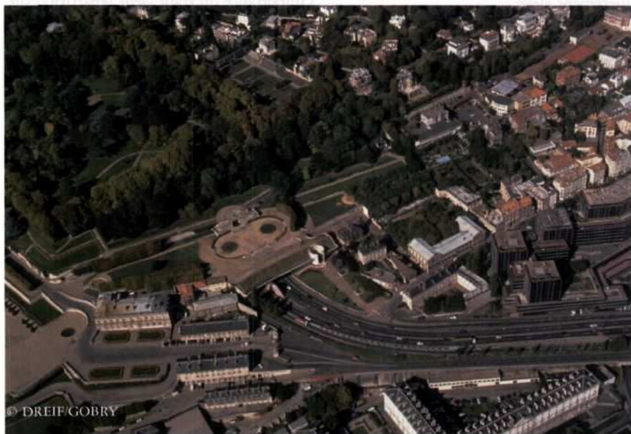
Vue aérienne entrée du tunnel de St Cloud
