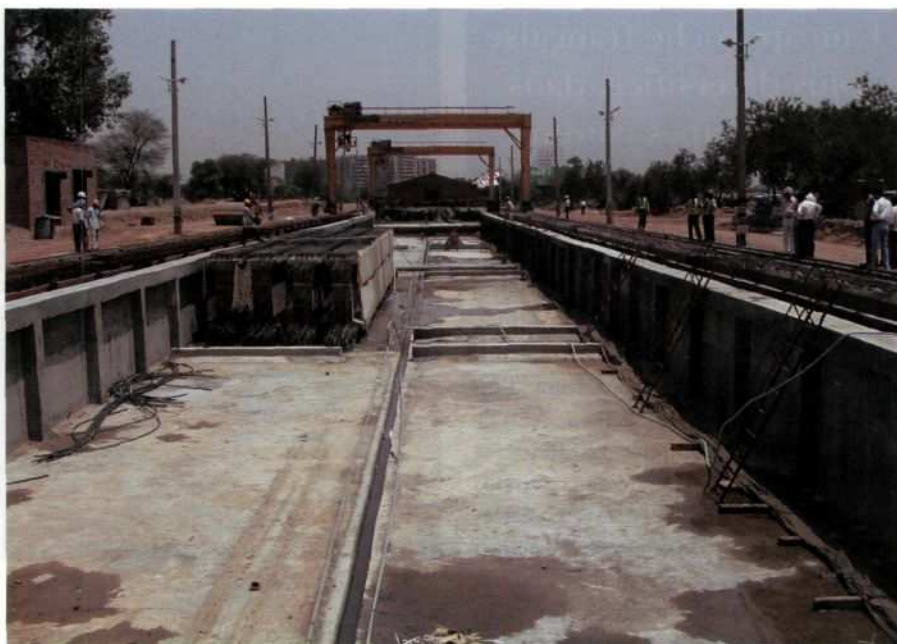
Atelier de poutres préfabriquées pour ouvrage autoroutier près de Delhi
