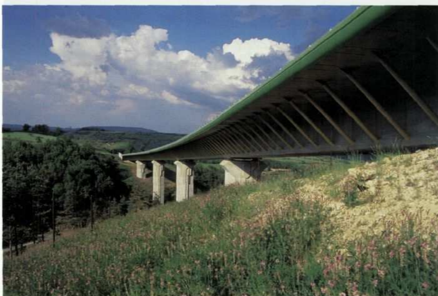
Viaduc du Rioulong - A75 (Lozère)
