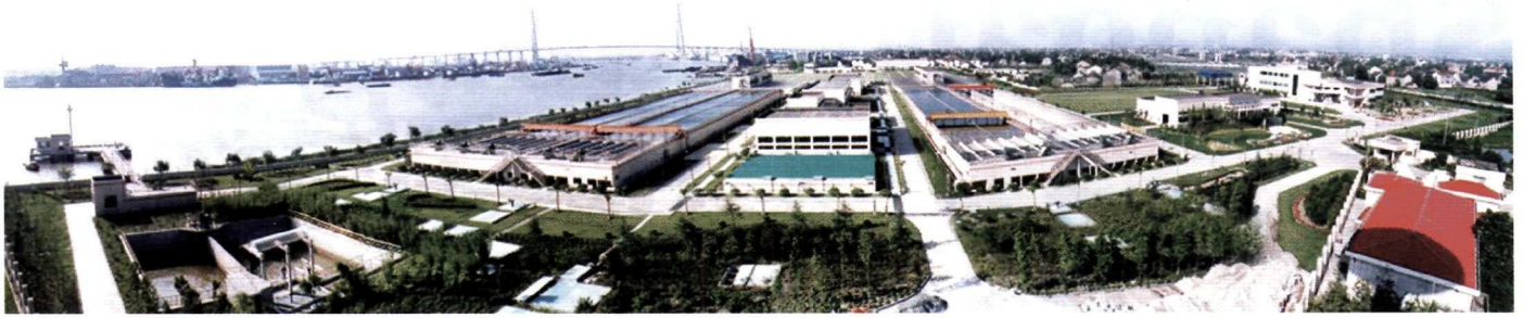
Usine de Traitement de Linjiang
