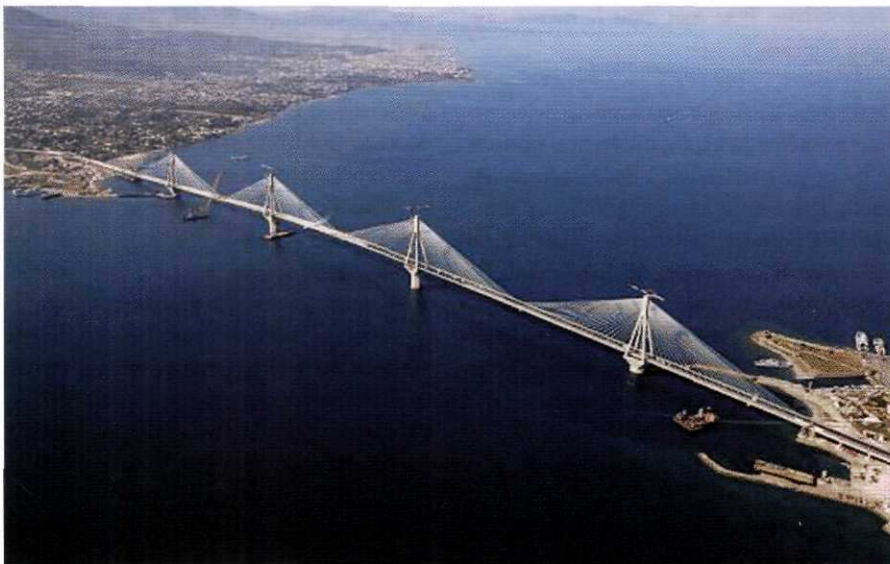
Pont de Rion Antirion
