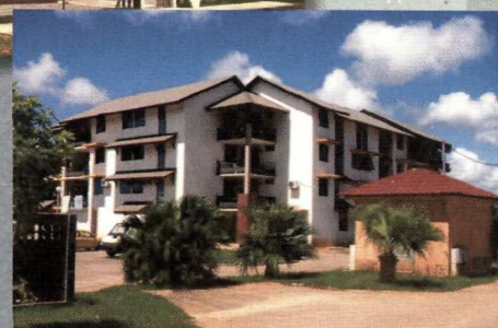
Novaparc Cayenne - 90 LLS (Architecte : S. Karpoff)
