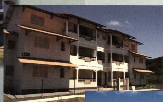
Saint-Martin Cayenne - 120 LLS/LLTS (Architecte T. Audureau)
