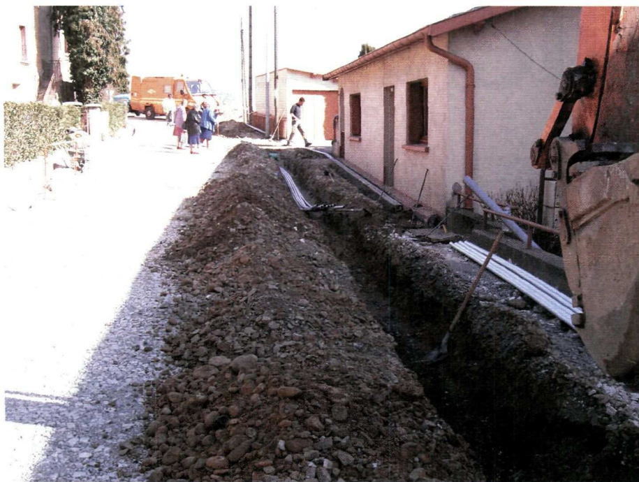
une tranchée avec pose d'une fibre haut-débit, légende : réseau d'eau, réseau haut-débit ou les deux
