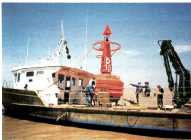
Travaux de balisage
