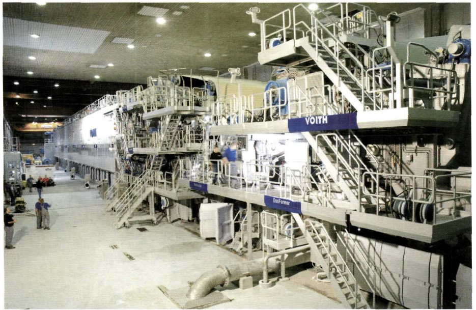
Equipements électriques et mise en service d'une machine à papier pour Stora en Allemagne
