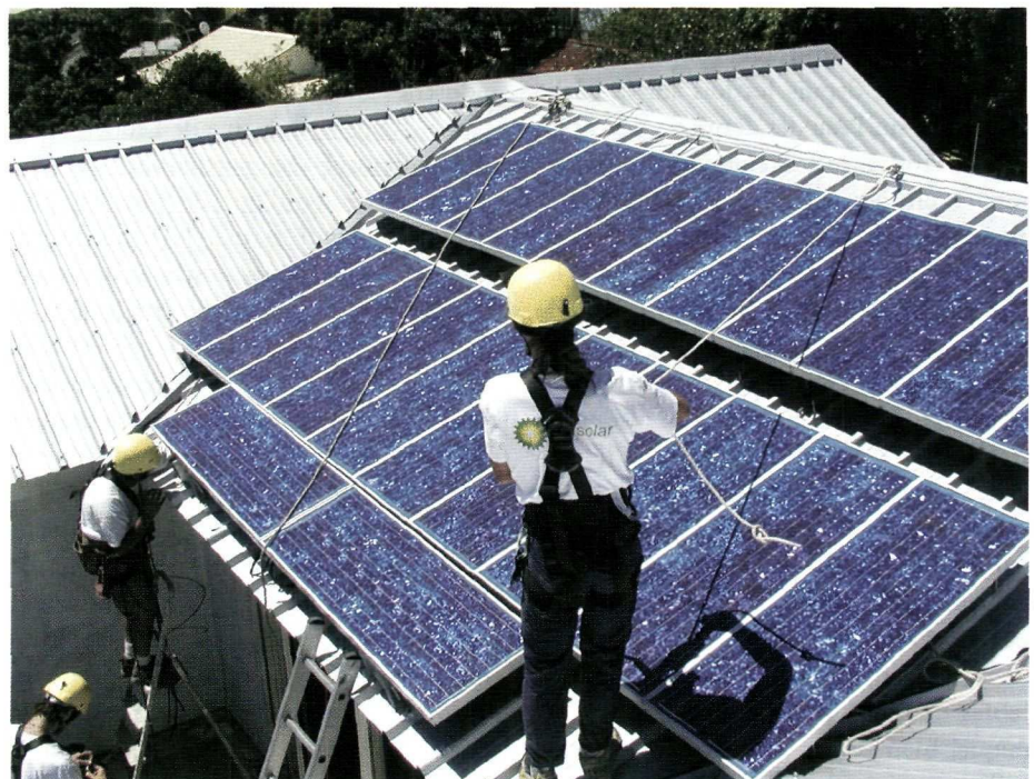
Installation de panneaux photovoltaïque en Toiture
