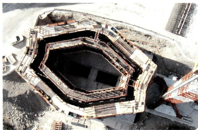
Fût de pile P2 - vue de dessus
