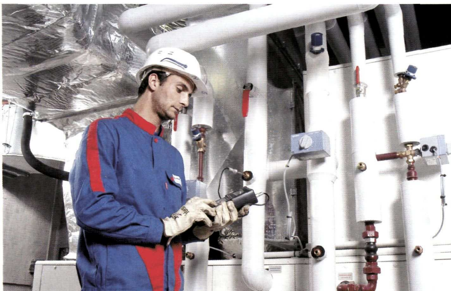
Rénovation (courants forts, courants faibles, climatisation, ventilation et chauffage) de blocs opératoires - Hôpital de La Timone (Marseille)
