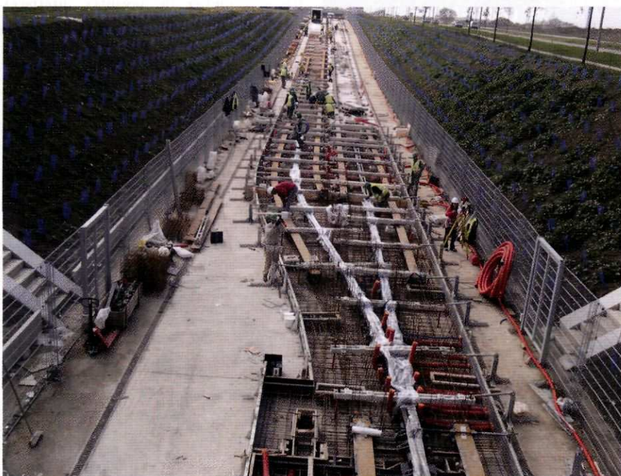
Pose de la voie
