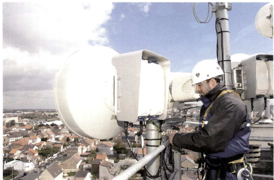
Installation de faisceaux hertziens pour SFR (Paris)
