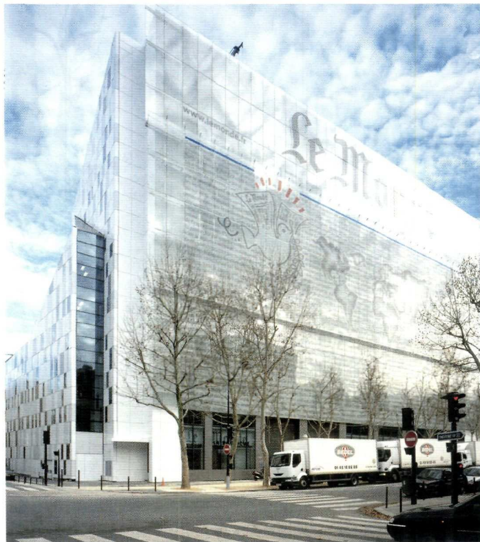
Réseaux d'énergie et de communication du nouveau siège du journal Le Monde ( Ile-de-France)
