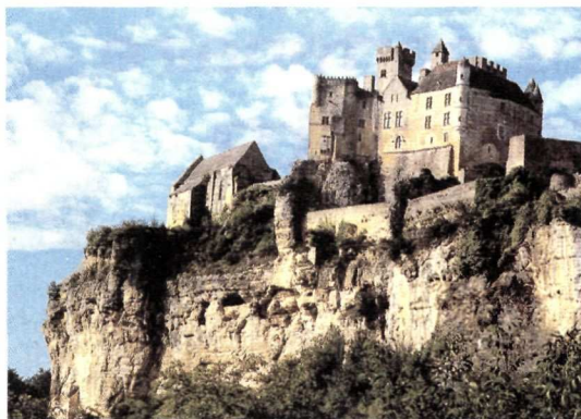
Monuments Historiques inadaptés à la protection contre l'Incendie
