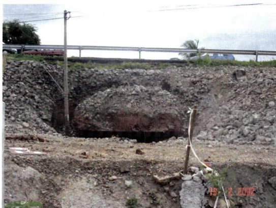
Poussage terminé. Vue de l'amont. La masse d'enrochements a servi à stabiliser le talus pendant le poussage. La hauteur de la chaussée au dessus de l'ouvrage est en moyenne de 4 m.
