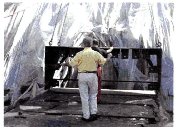
Mise en place du bec.
