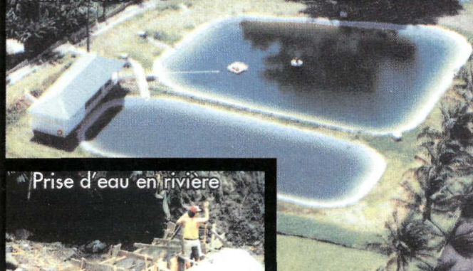
Lagunage de la distillerie Depaz Saint Pierre
