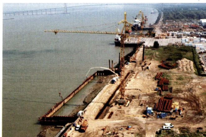
Vue aérienne du chantier - Bétonnage des pieux de la file 2
