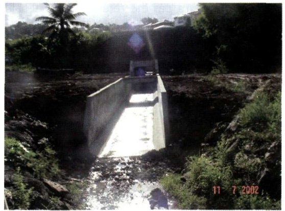
Ensemble de l'ouvrage terminé.
