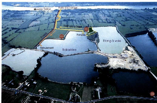
La ballastière d'Yville et son équipement
