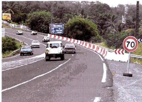
Vue de la chaussée : des travaux en sous œuvre, permis par la topographie, sans incidence sur le trafic.
