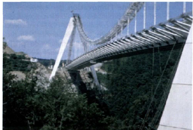
Viaduc de Chavanon
