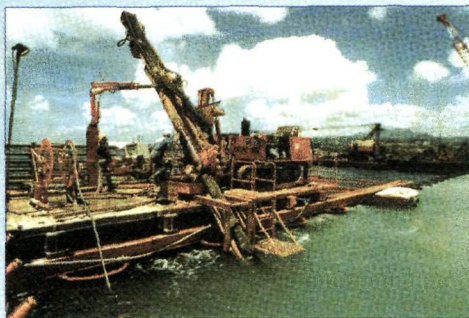
Nouveau terminal a conteneurs de la Pointe des grives - Micropieux (Capacité 400 tonnes)
