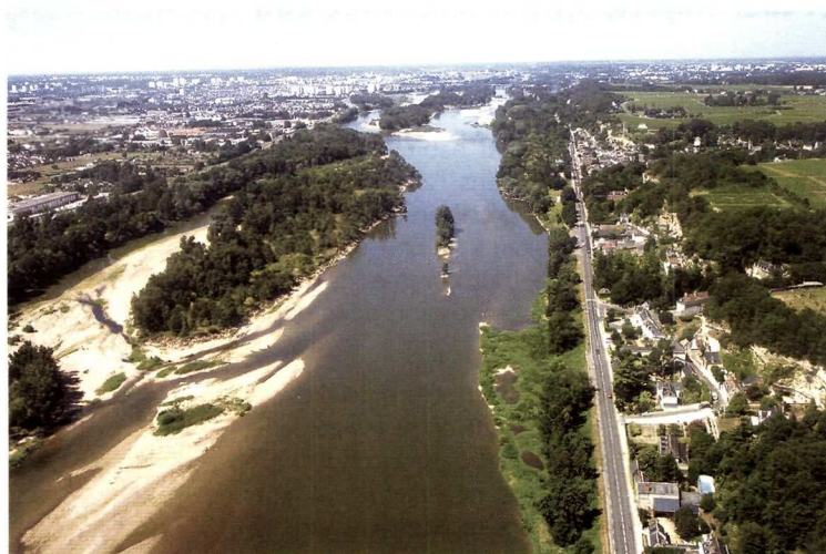
Crédit photo : COPIROUTE
