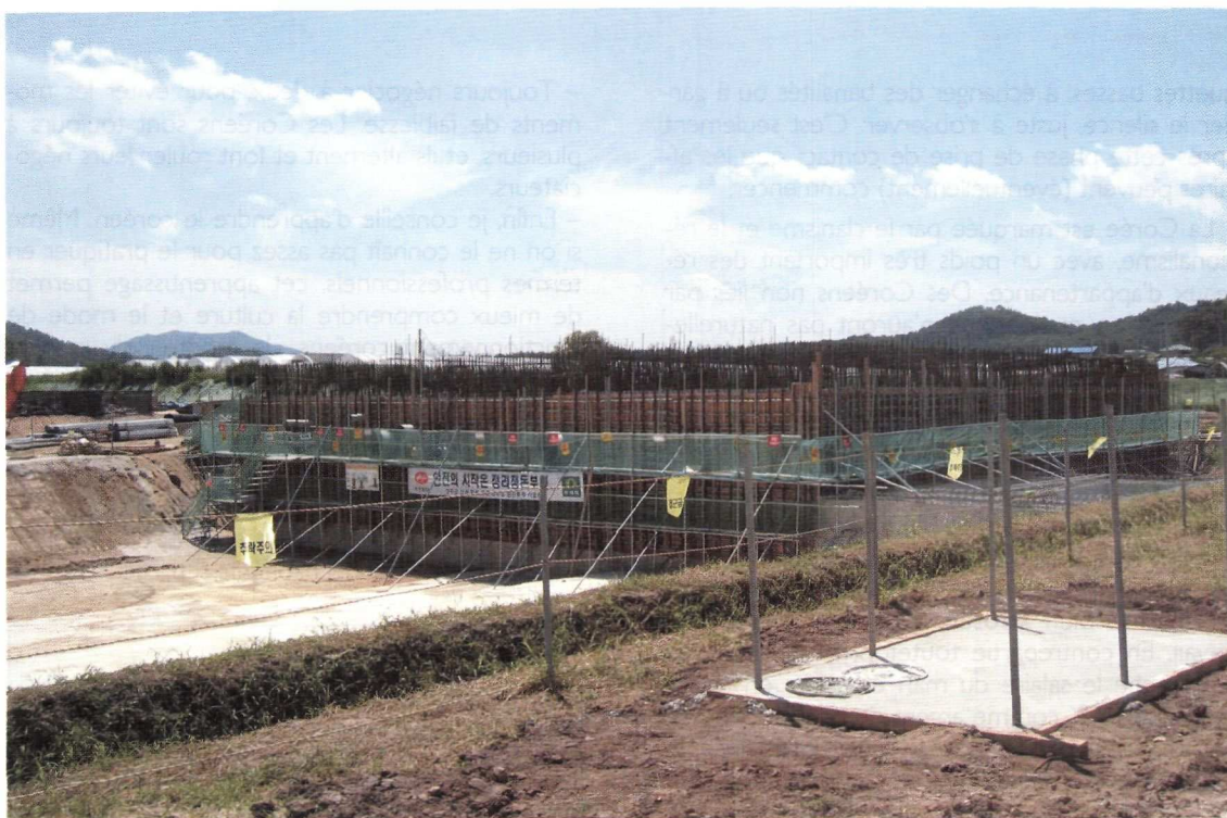
Le chantier en août 2003 : ça pousse !
