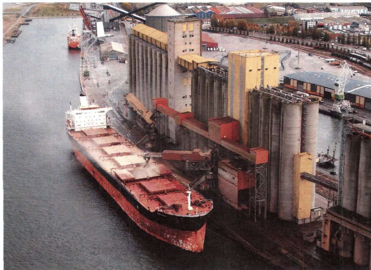
Silos céréaliers de la presqu'île Elie tournés vers l'exportation maritime. Rouen est le 1 er port exportateur européen de céréales. La position de port d'estuaire aux portes de Paris et du grenier agroalimentaire de la France permet de réaliser d'importantes économies.
