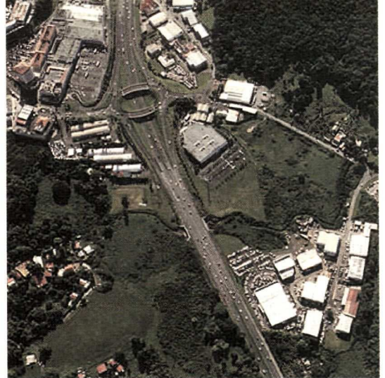
Autoroute A1 non encore transférée. Un oubli de la loi. Elle devra être transférée avec son cortège de règlements afin de préserver la sécurité des usagers.
