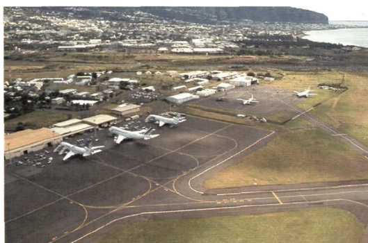
Vue aérienne de l'aéroport de Saint-Denis-Gillet (La Réunion).
