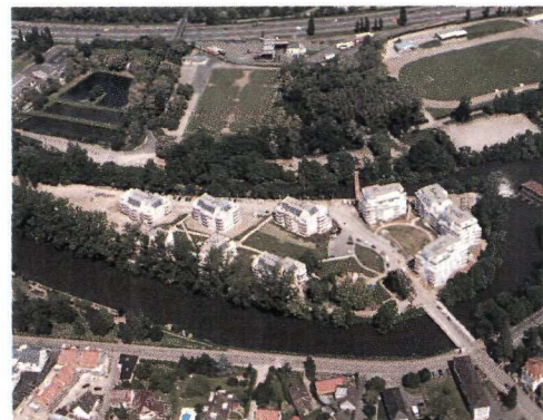
Illkirch (Strasbourg) - Architectes : Geoffroy, Jacquin, Apprill. Photo : Roger ROTHAN
