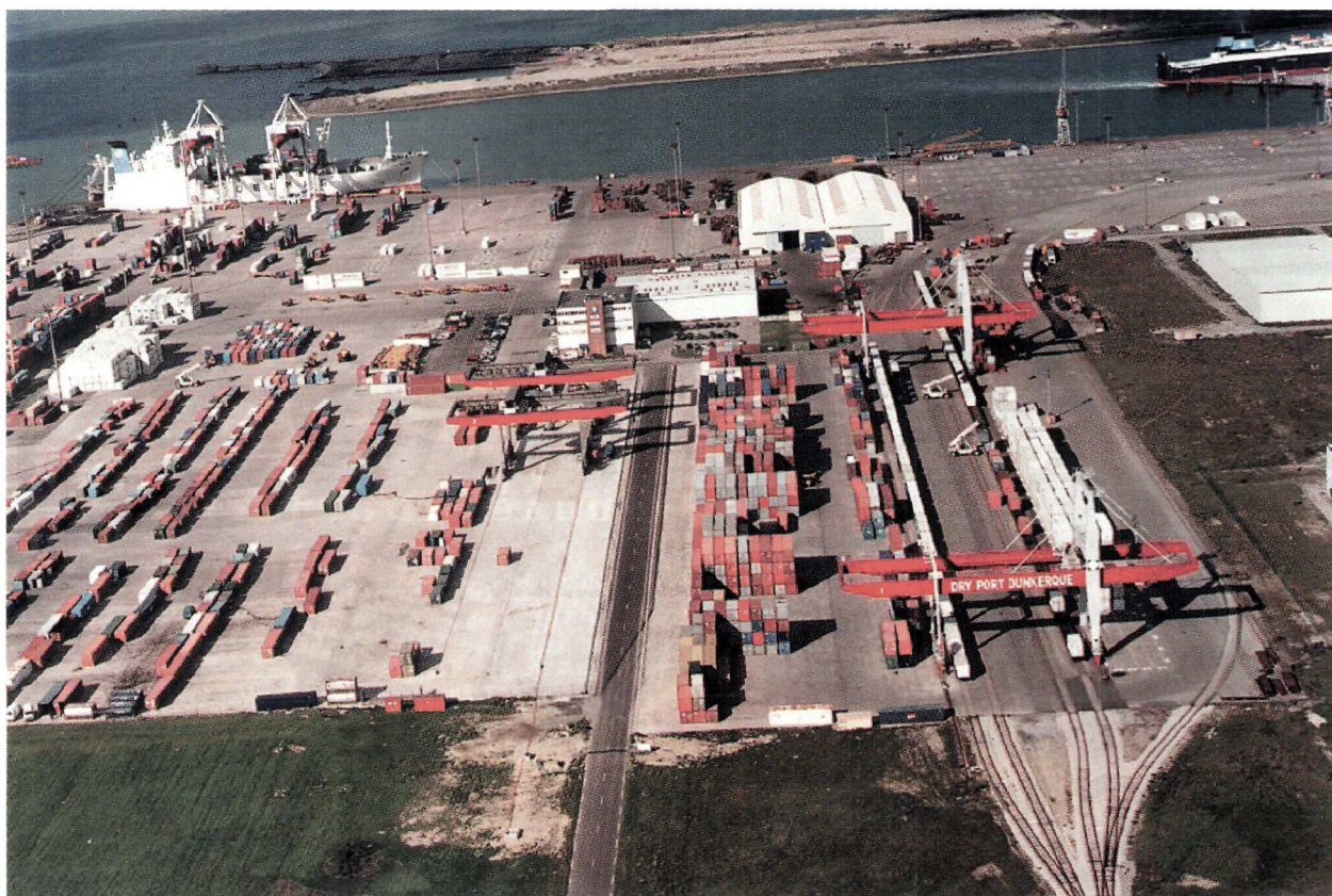
Port Ouest de Dunkerque : le terminal à conteneurs et le "dry port". photo : PAD/BDL
