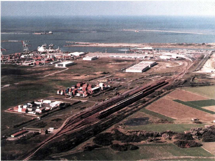
Port Ouest de Dunkerque : le terminal à conteneurs, le terminal ro-ro et la zone logistique. Photo : PAD/BDL
