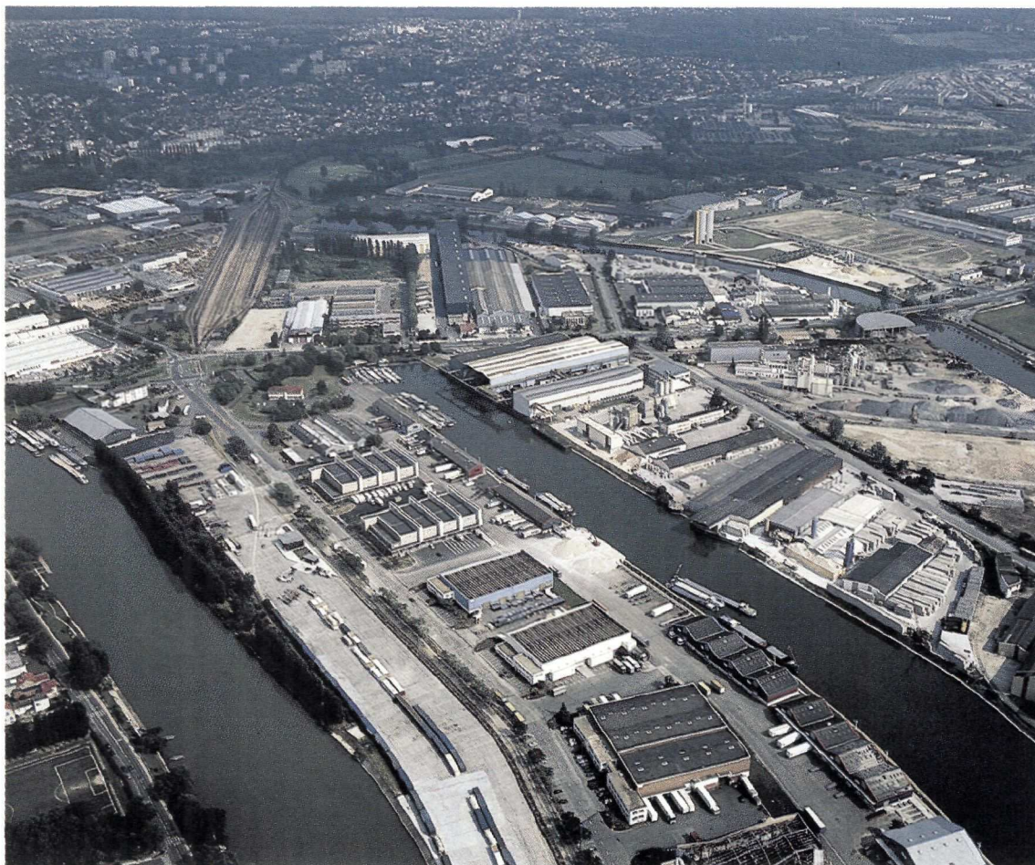
Le port de Bonneuil-sur-Marne (Val-de-Marne) dispose de remarquables infrastructures ferroviaires et fluviales. Photo : Port Autonome de Paris / La précision photographique
