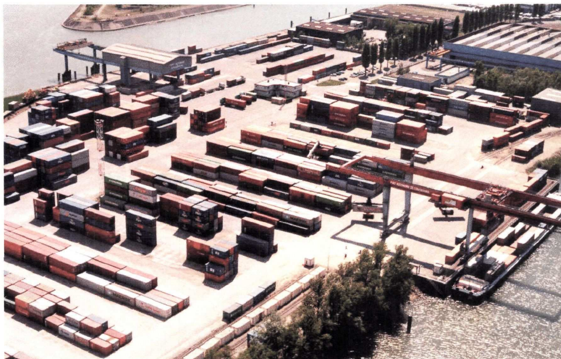
Terminal à conteneurs actuel.
