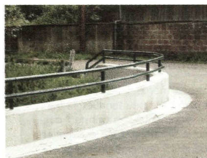
REHAUSSE SUR PARAPET
