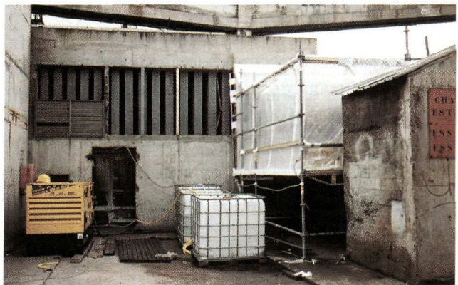
Vue extérieure d'un confinement (en site industriel abandonné) pour enlèvement de calorifuge.
