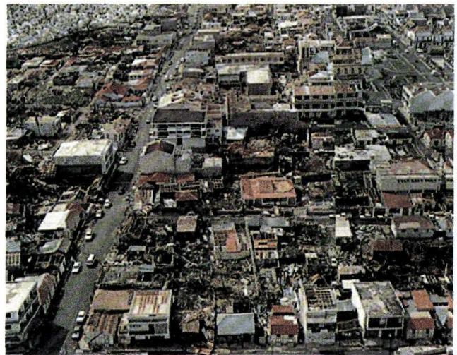
Les communes de la Guadeloupe qui ont subi les vents les plus forts ont été dévastées. Les toitures ont été arrachées, les maisons en bois ont volé en éclats. Photo P. Giraud
