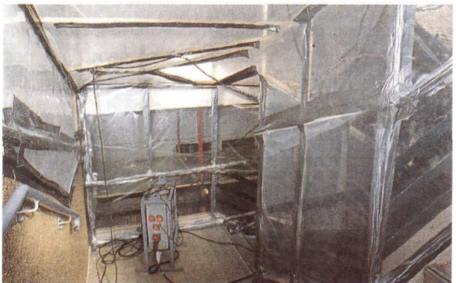
Vue intérieure d'un calfeutrement pour enlèvement de dalles de sol + colle.
