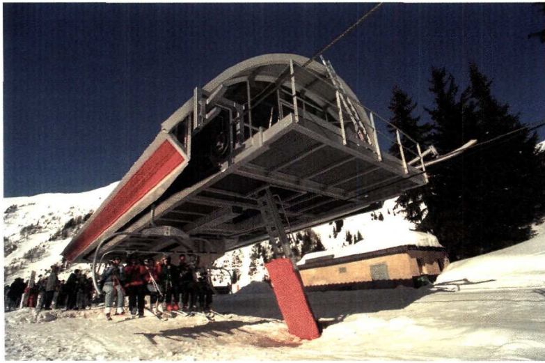
Gare départ télésiège 6 places La Rossa à la Plagne.
