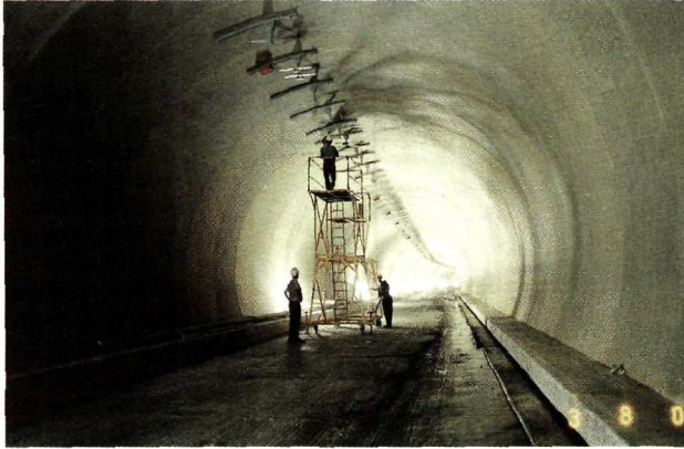
Mise en place du revêtement de protection au feu.
