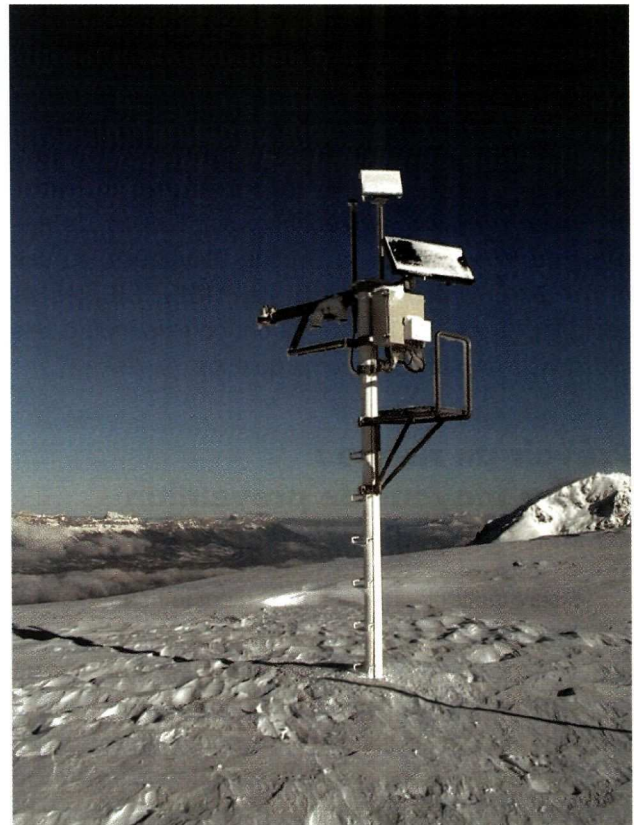
Station automatique Nivôse installée à 2250 m d'altitude près de la croix de Chamrousse (massif de Belle-donne). Vitesse du vent, température de l'air, hauteurs de neige au sol sont mesurées au pas horaire et transmises par balise Argos. (Crédit Photo D. Lecorps - Météo-France/CEN).
