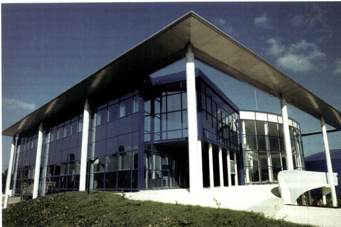
Station d'épuration d'Annecy.
