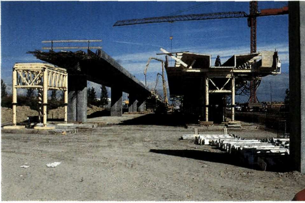
Figure 4 - Viaducs dans le secteur de Bella-Center
