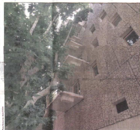
Les jardinières intégrées au balcon. L'une des multiples idées de l'"immeuble vert".
