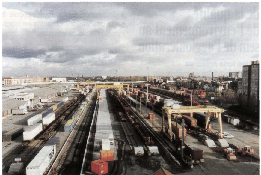
Lille-Saint-Sauveur : un chantier de transport combiné facile d'accès.
