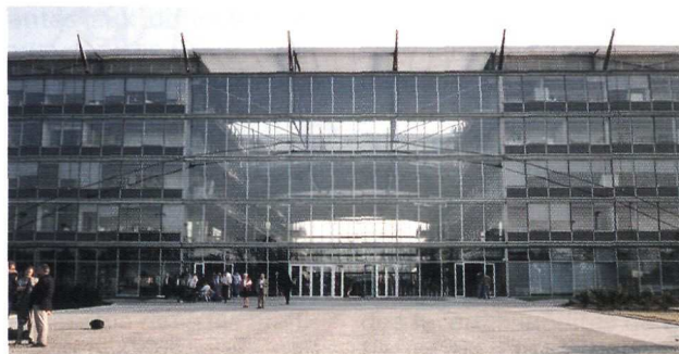
L'école des Ponts et Chaussées à Marne-la-Vallée.
