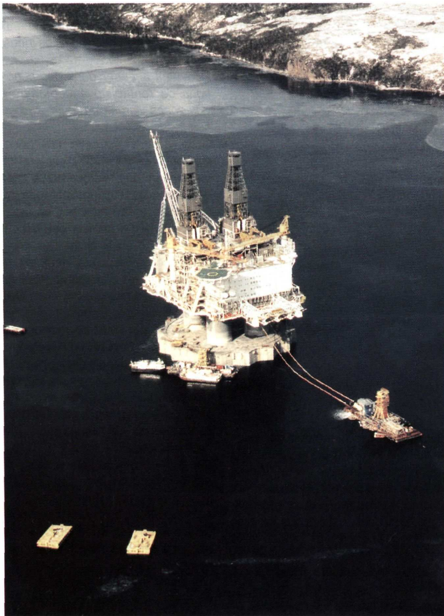
Hibernia, plate-forme pétrolière au large de Terre-Neuve. Conçue par Doris Engineering, cette plate-forme est avec ses 1,3 million de tonnes, le plus lourd objet marin au monde, et résiste à des chocs et icebergs pesant jusqu'à 6 millions de tonnes. Photo de la phase de remorquage après construction.
