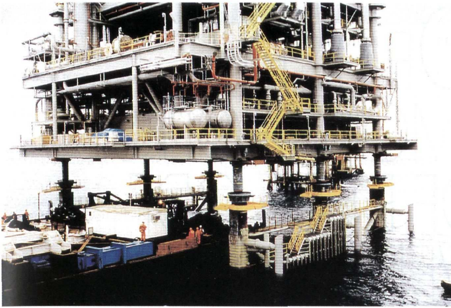
SMARTLEG, conçu et réalisé par ETPM consiste à remplacer les habituels mais encombrants engins de levage, par des vérins hydrauliques, pour placer sur son support une plate-forme pétrolière. Ci-dessus, la barge se retire après avoir placé le "decle" de 4 000 tonnes sur ses pieds.
