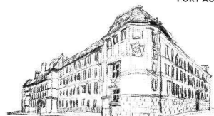
RENOVATION DU LYCEE LOUIS LE GRAND PARIS - FRANCE
