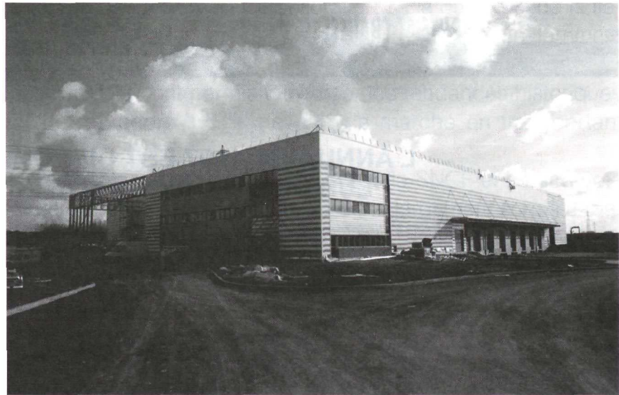
Chantier de construction de l'entrepôt DAHER.
