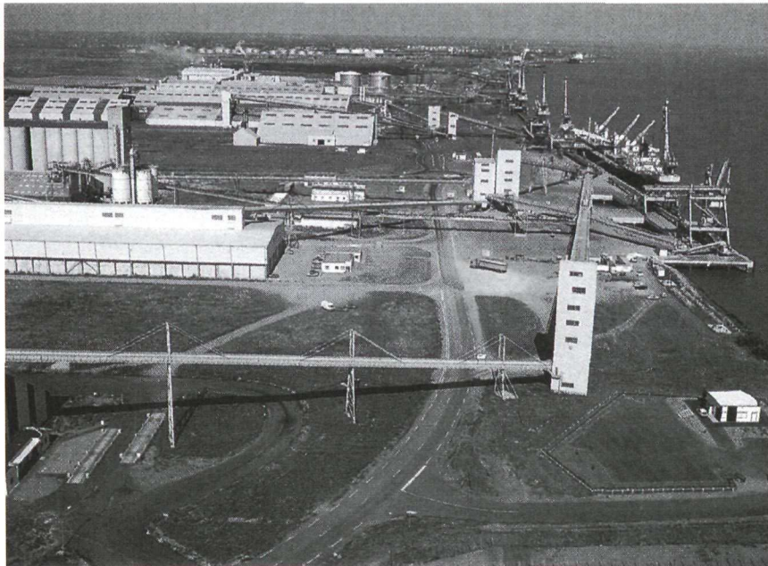
Terminal agro-alimentaire de Montoir. Les opérateurs privés ont investi massivement dans des stockages spécialisés. Les grues et les bandes sont propriété du Port Autonome et opérées par lui.
