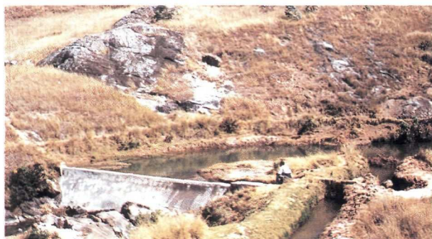
Le barrage terminé.
