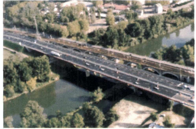
Pont du périphérique et pont SNCF sur la Garonne.
