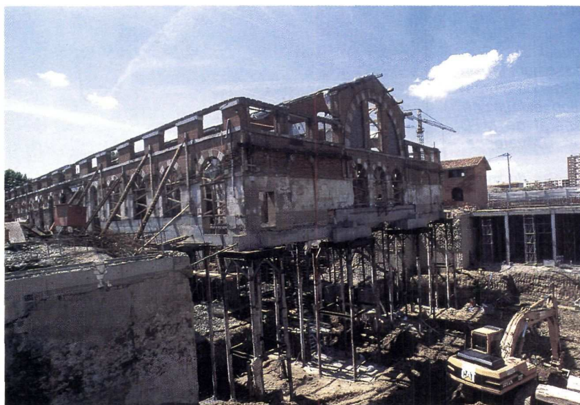
L'Espace d'Art Moderne et Contemporain - La reprise en sous-œuvre de la Grande Halle d'Urbain Vitry.
