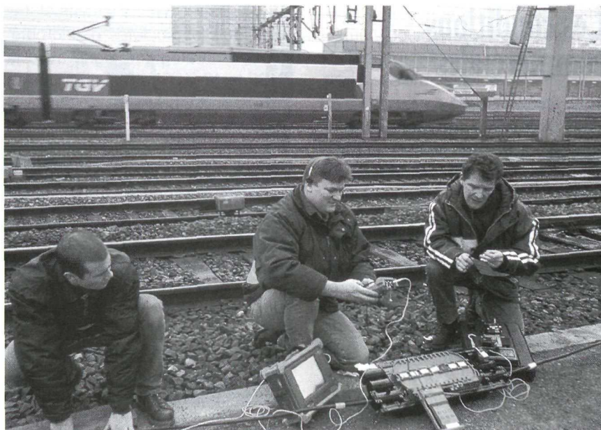
Pose de fibres optiques le long de la voie TGV.
