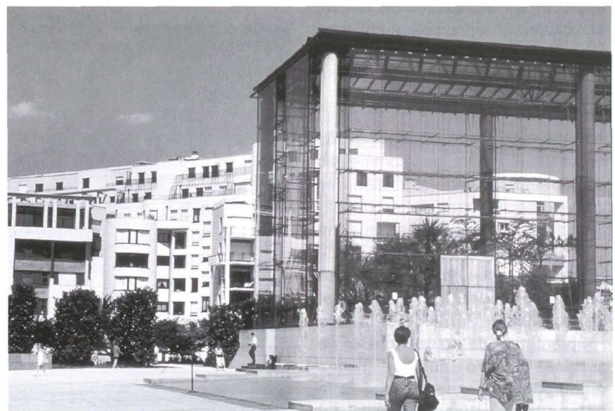
Le parc André Citroën - Une de ses deux serres monumentales et son environnement bâti.
