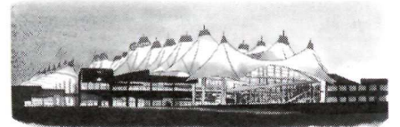
AÉROPORT INTERNATIONAL DE DENVER - COLORADO - ÉTATS-UNIS
