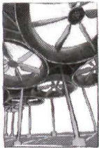
USINE DE PRODUCTION D'ÉLECTRICITÉ THETFORD - ROYAUME-UNI
