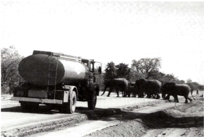
Réalisation du tronçon de la RN 1 de Parabou à Djougou.
