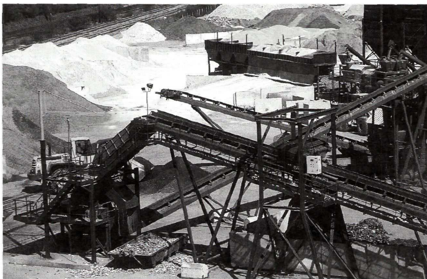
Les matériaux sont au premier plan de l'innovation routière. Le centre de traitement de Massy permet la valorisation des mâchefers d'incinération d'ordures ménagères.
