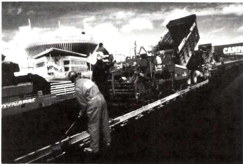
Réfection du revêtement du circuit de Formule 1 "Gilles Villeneuve" à Montréal.
