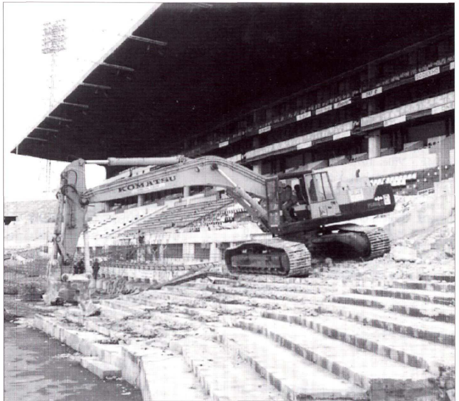
Démolition des gradins actuels.
