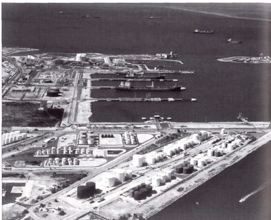
Marseille : Bassins Ouest, les installations de Laréra.
