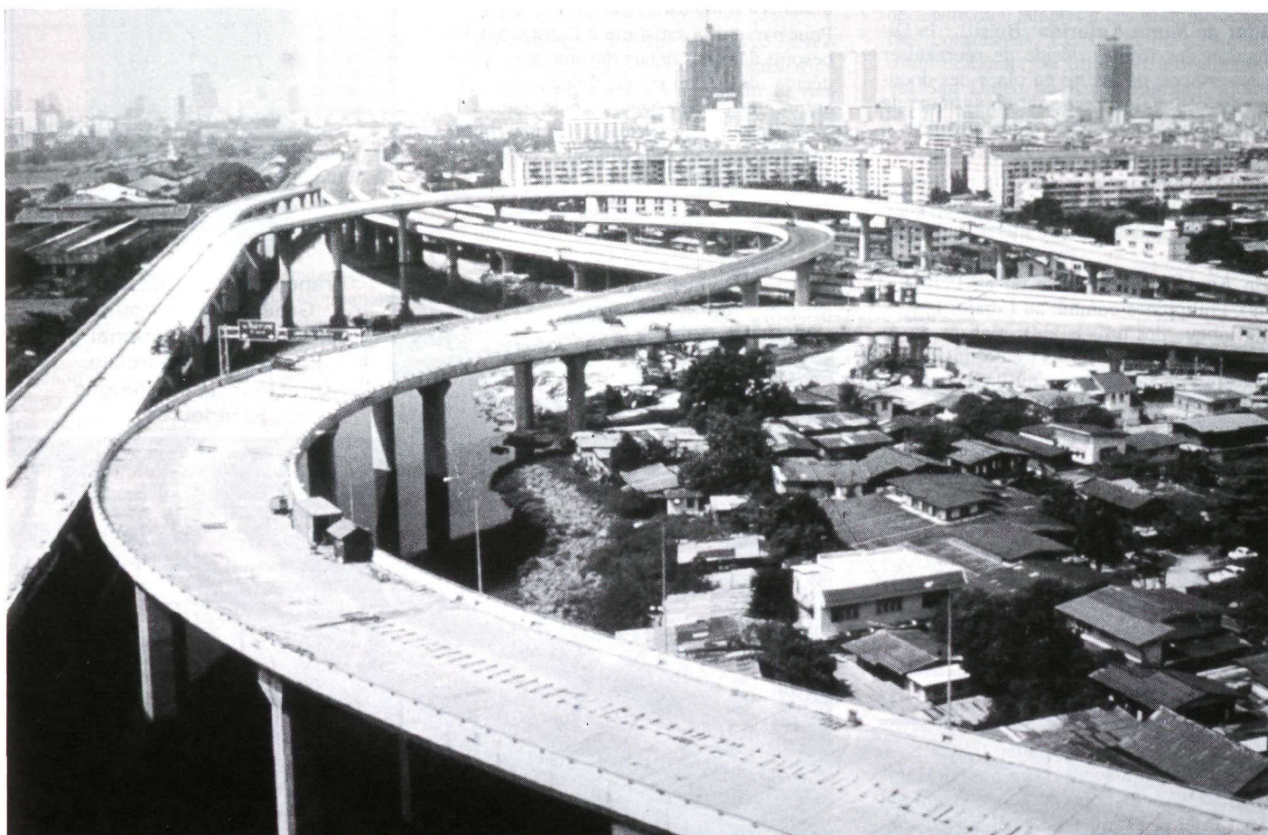
Le réseau d'autoroutes surélevées de Bangkok, vue aérienne d'un échangeur (Photo Scetauroute).
