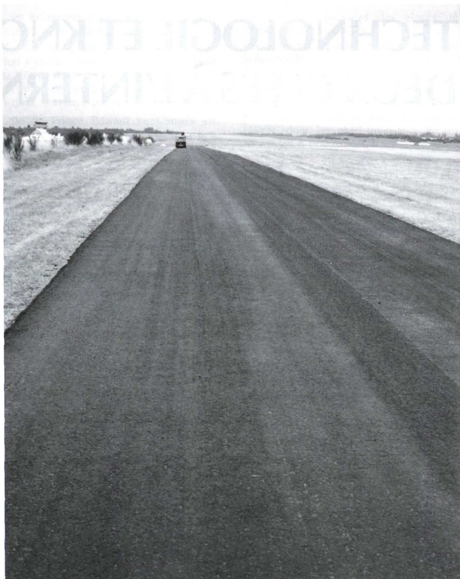
Le Gripfibre ® , enrobé coulé à froid, a fait ses preuves notamment en Nouvelle-Zélande.
