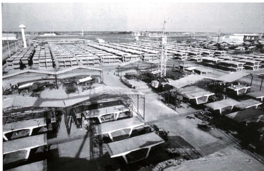
Bangkok : L'usine de préfabrication des voussoirs.
