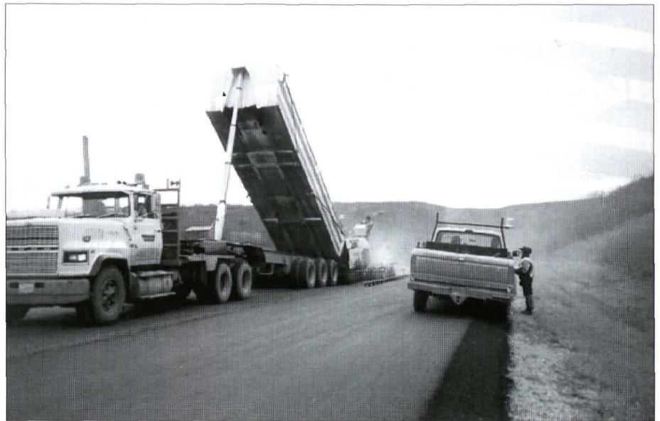
Application d'enduits bitumineux dans l'Alberta.
