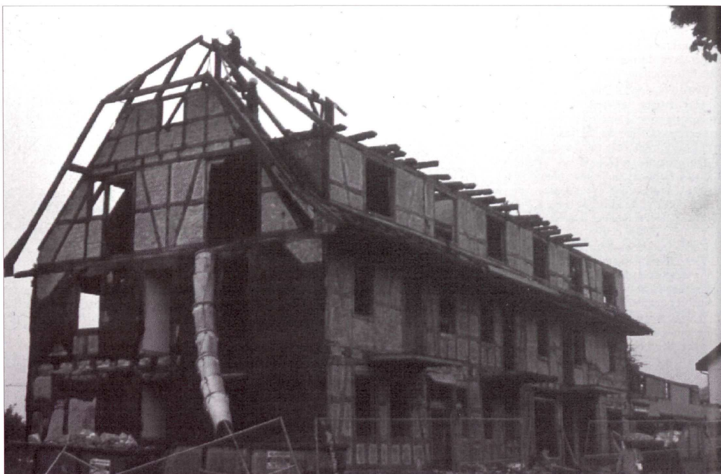
Chantier pilote de déconstruction sélective de l'Hôtel Post à Dobel ayant permis le recyclage de 94 % des matériaux
