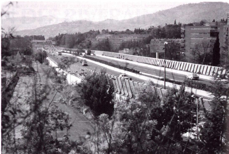
Traversée de Mandelieu. Écrans transparents, plantations sur la glissière et le terre-plein central. (Photo ESCOTA.)
