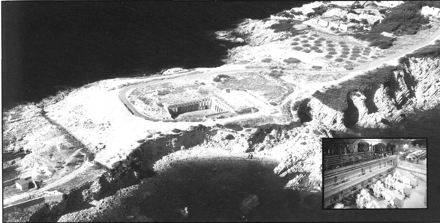
Station d'épuration souterraine de SANARY-BANDOL
