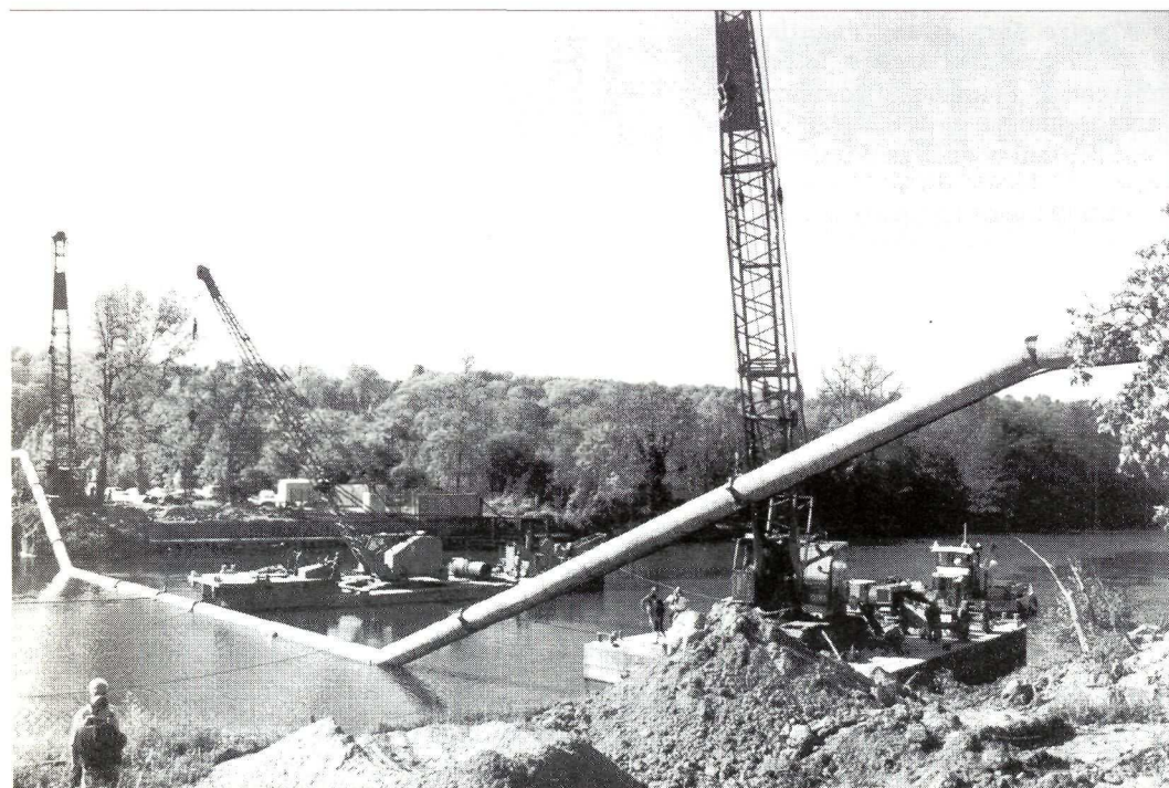
Le flottage du tuyau avant son immersion.
