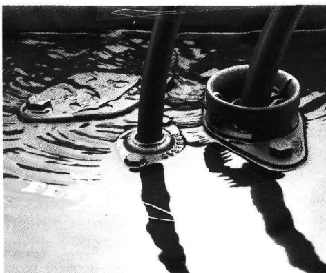
Station de pompage des eaux usées « l'lette ». Débit maxi : 2 100 m 3 /h à 5 m. Rééquipée de trois pompes FLYGT CT 3300 - 44 kW montées horizontalement en « fosse sèche ».
