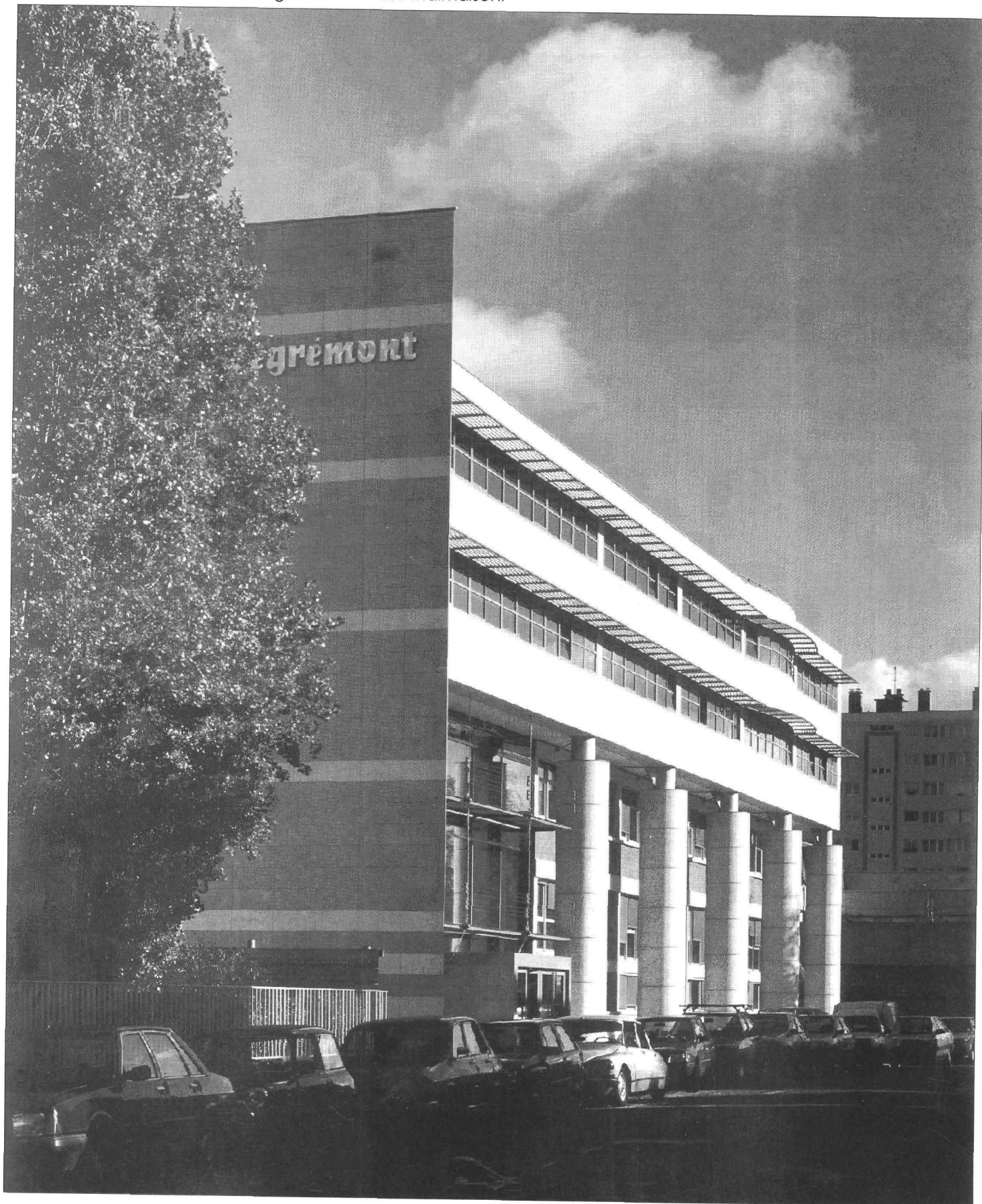
Le nouveau siège social de Degremont à Rueil-Malmaison.
