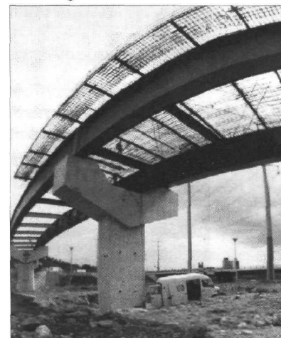
Échangeur A 86, Créteil.
