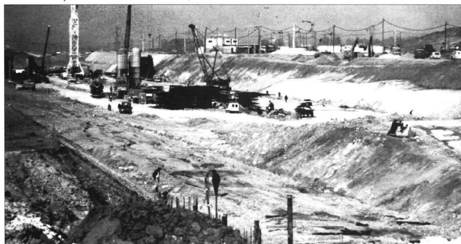
Eurodisneyland : Tranchée RER/TGV.
