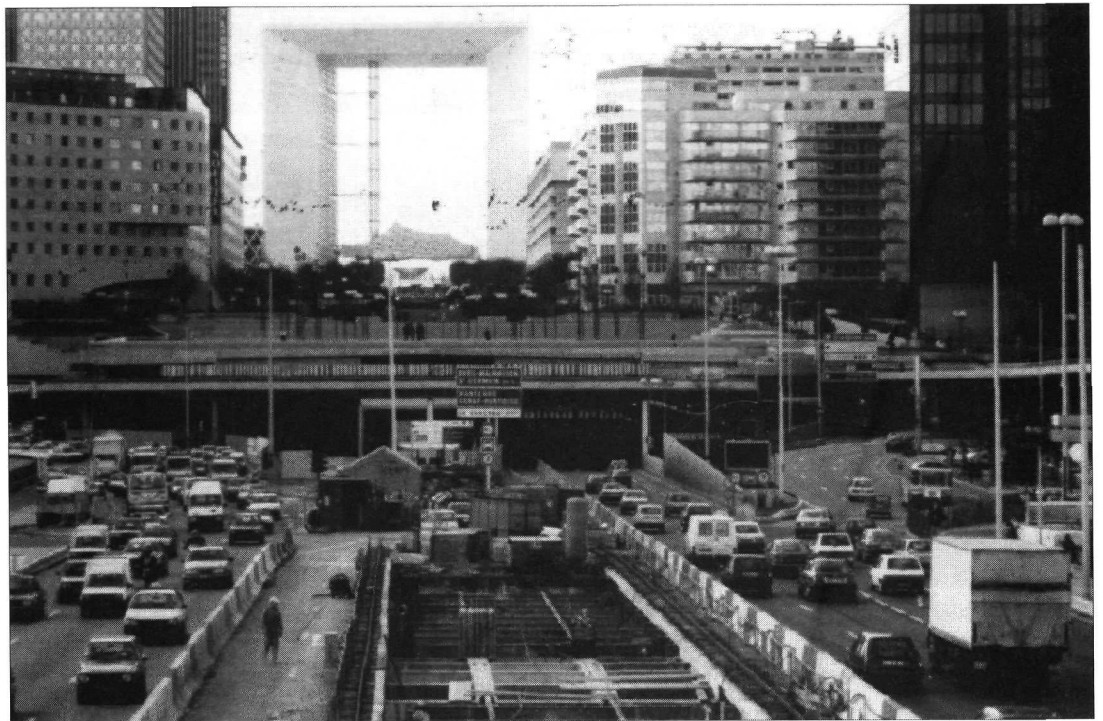
Travaux de prolongement, ligne Métro n° 1.
