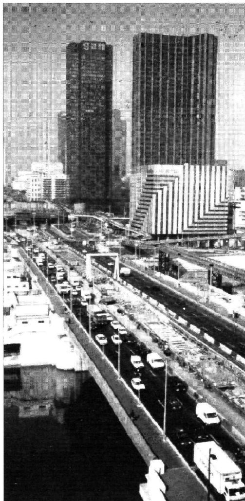
Travaux de prolongement n° 1. Renforcement du Pont de Neuilly.
