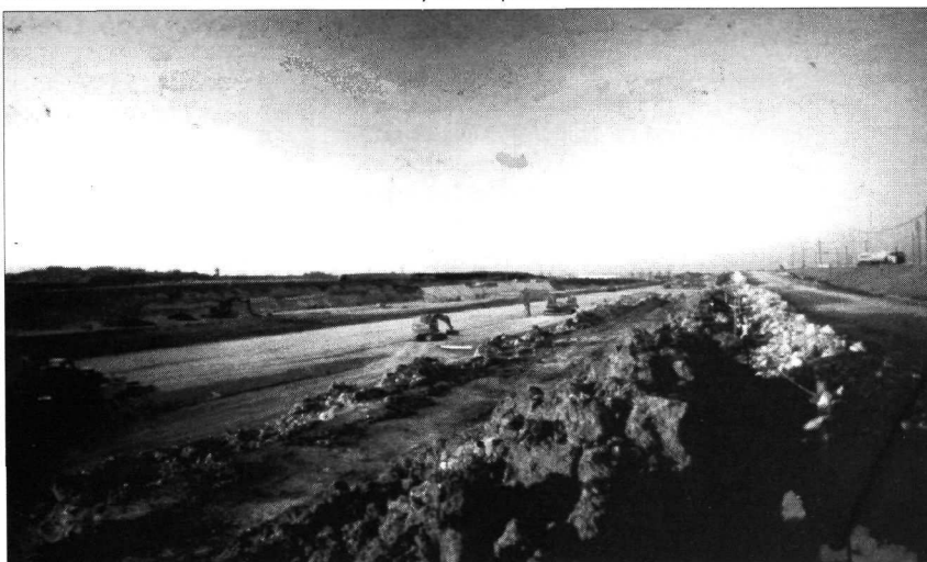
Tranchée dans le site Eurodisneyland pour TGV et RER.
