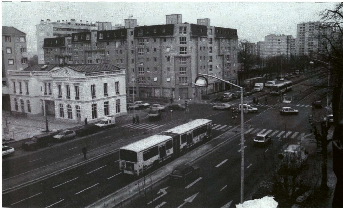
Le partage de la voirie (site propre sur la RN 305 source RATP).
