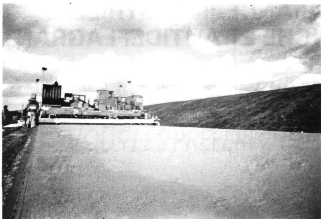
Machine à coffrage glissant.
