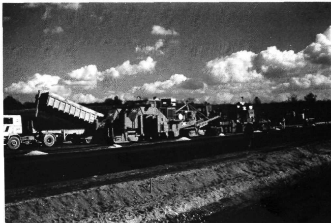
Train de mise en œuvre.
