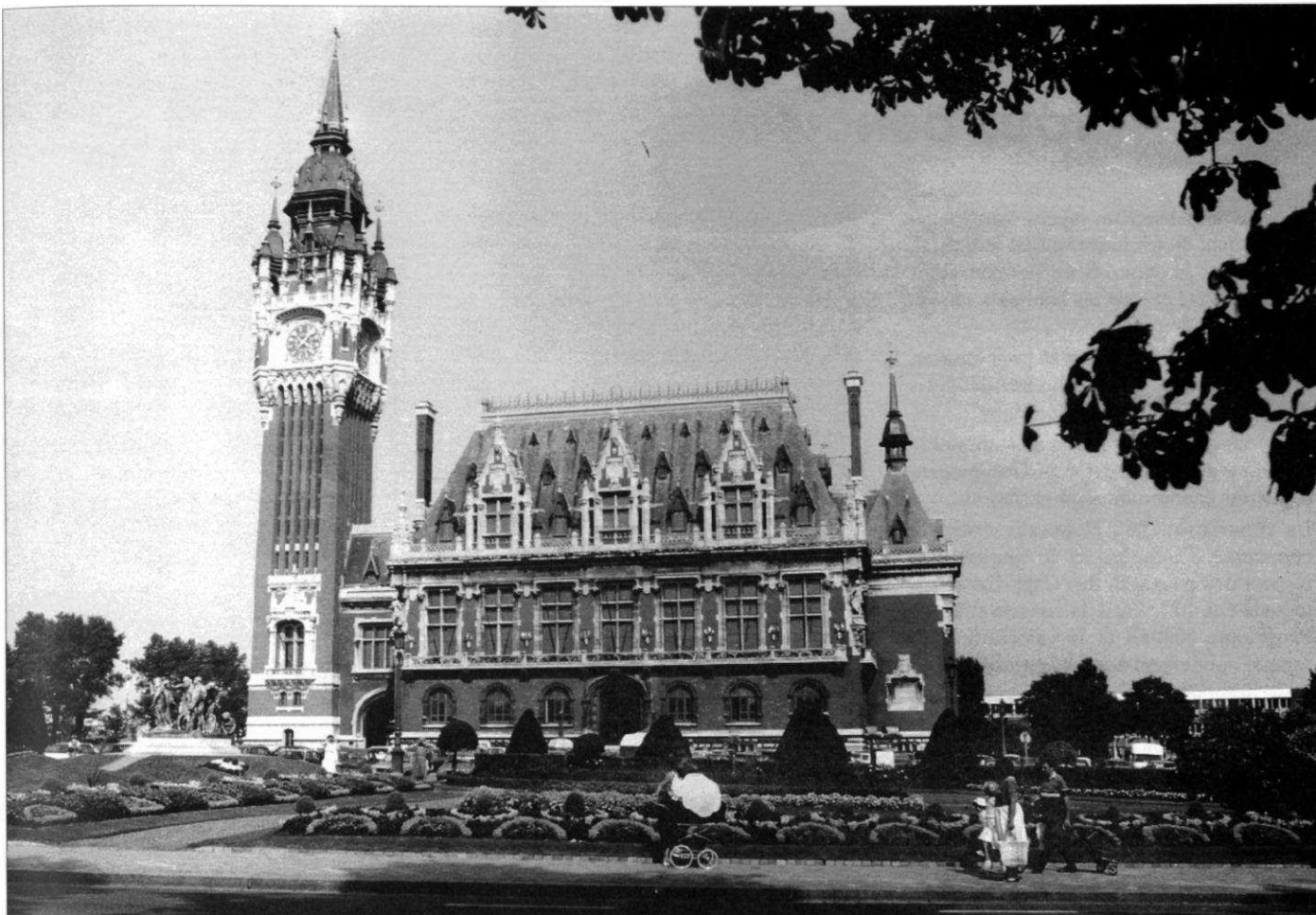
Achevé en 1927, l'Hôtel de Ville de Calais, de style « Renaissance flamande », est un des premiers bâtiments dont les structures ont été réalisées en béton armé.
