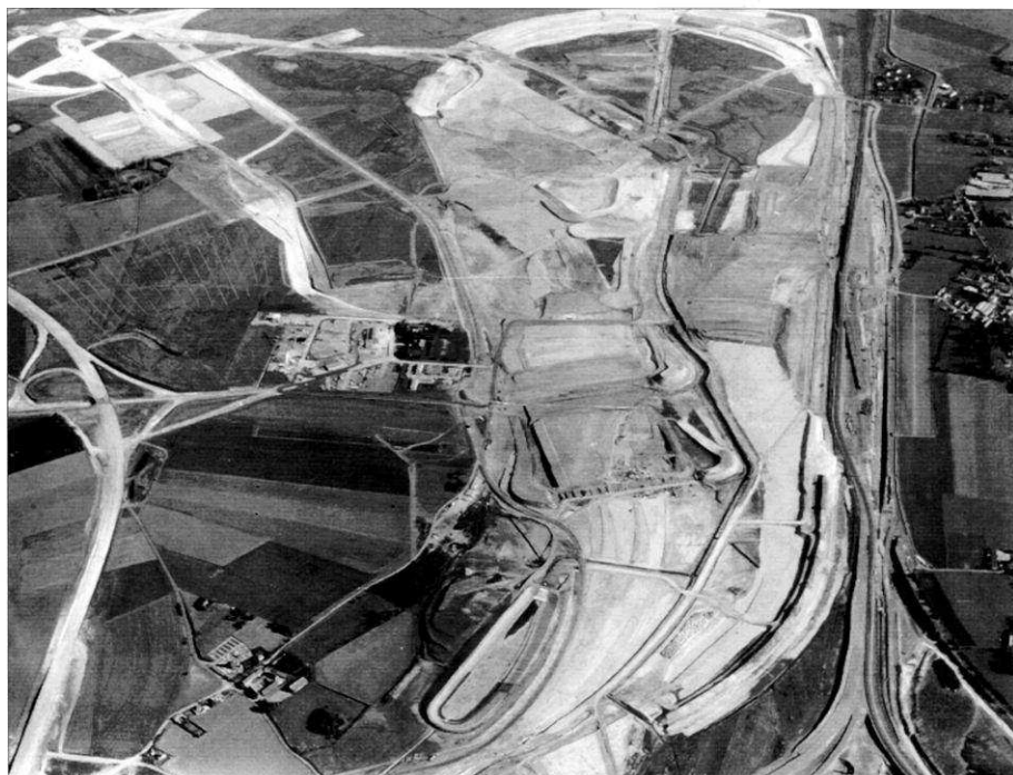
Avancement du chantier de terrassement en octobre 1989. Photo Phot'R.
