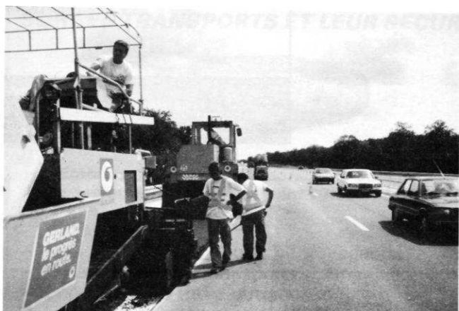
Quatrième étape : application du tapis d'enrobé sur le complexe anti-fissuration (intérêt grand)
