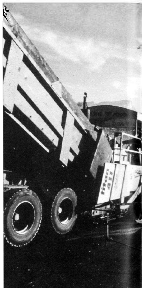
Mise en œuvre d'enrobés drainants
