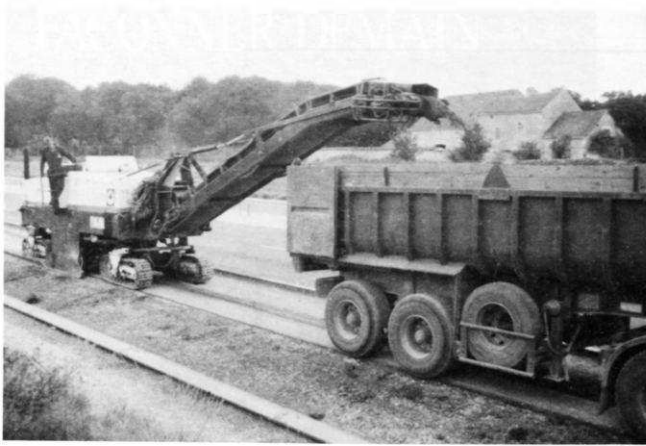
Première étape : fraisage du revêtement en surface (intérêt faible)
