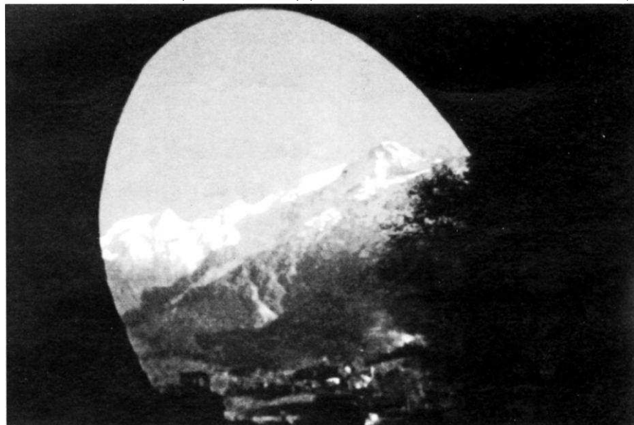
Tunnel des Chavants (Haute-Savoie) (Photo : D. Chabert - DDE Haute-Savoie).
