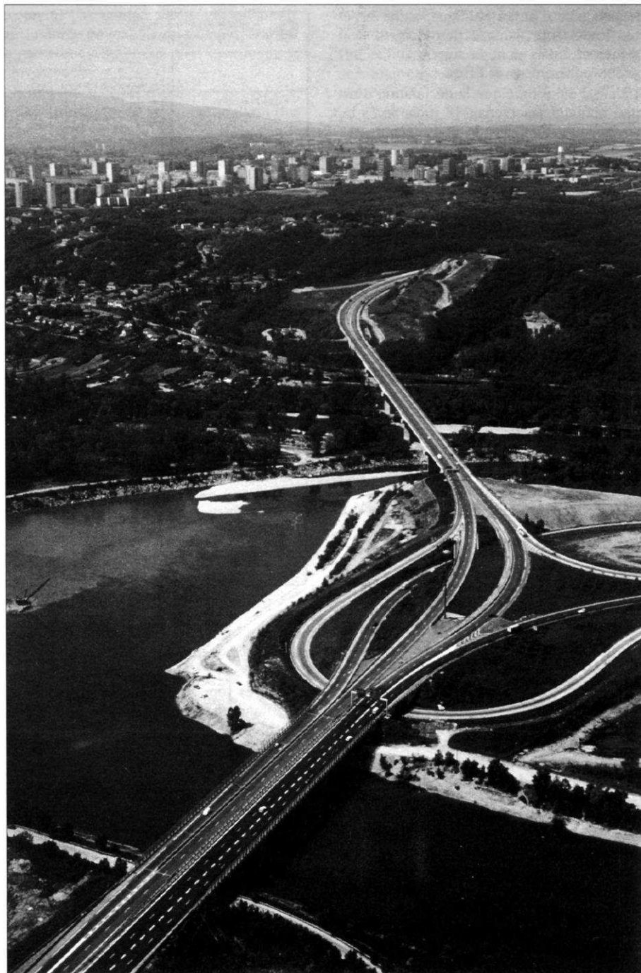
Autoroute A 46. Le nœud des Iles A 42/A 46 et le viaduc de Sermenaz.
