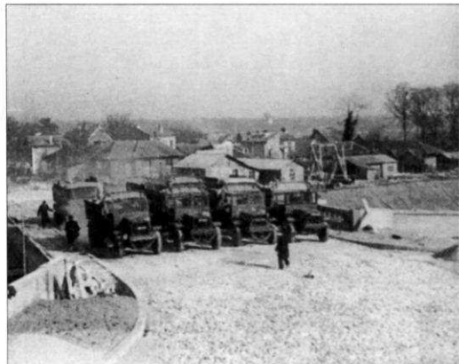
Travaux de construction de l'autoroute en 1938.
