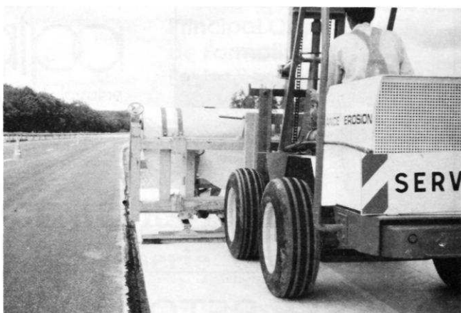
Troisième étape : pose de la membrane anti-fissuration sur le liant Routochape (intérêt moyen)
