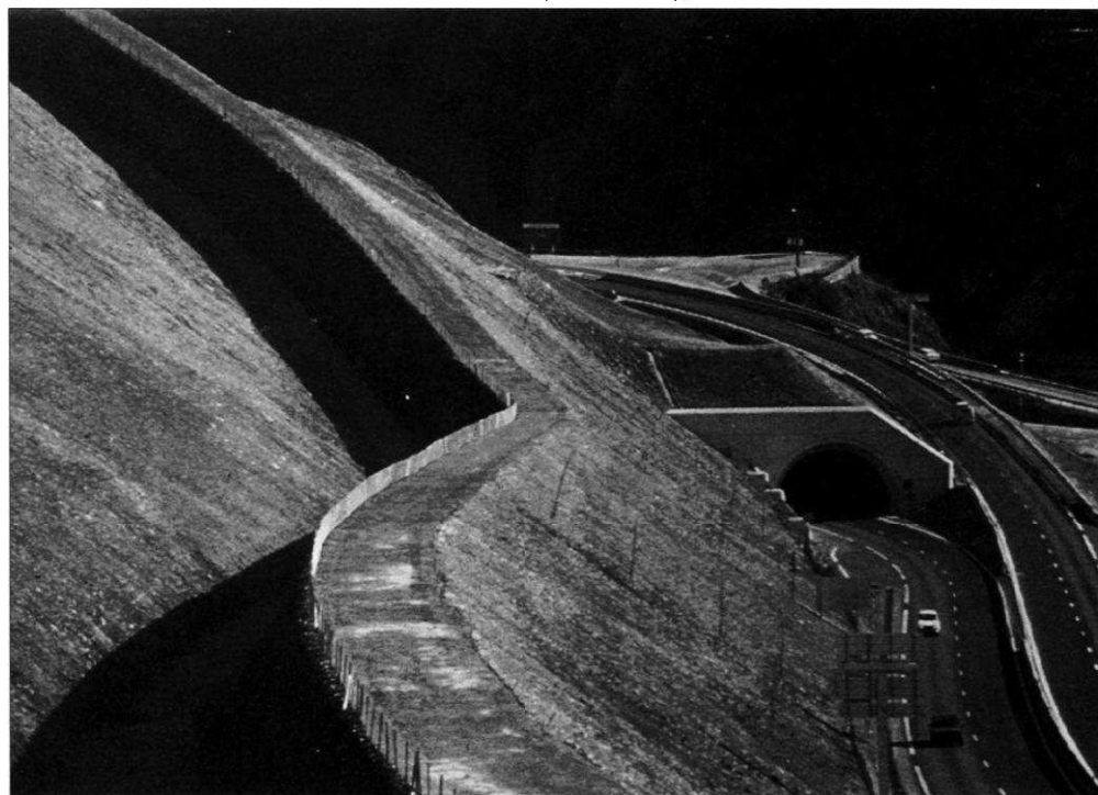
Tunnel de Ponserand (Savoie) (Photo : Guy Chaberty).
