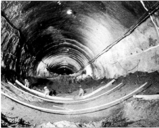
Tunnel A8 - Creusement d'un tunnel avec radier (Photo : Yannick Collet).
