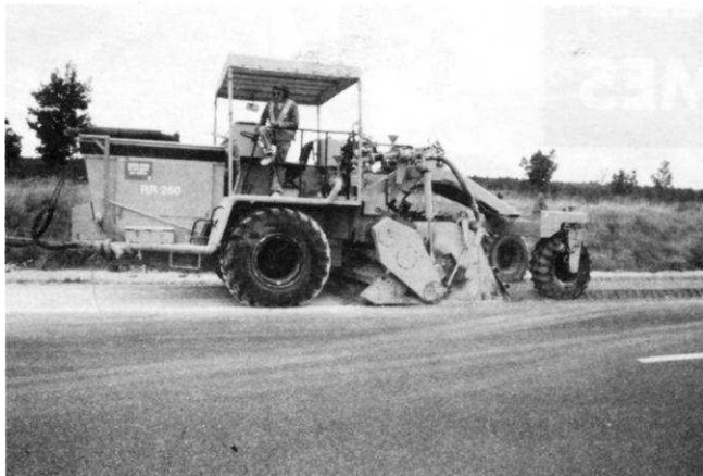
L'atelier de traitement de sol en place + détail de la machine RR 250 (intérêt moyen)
