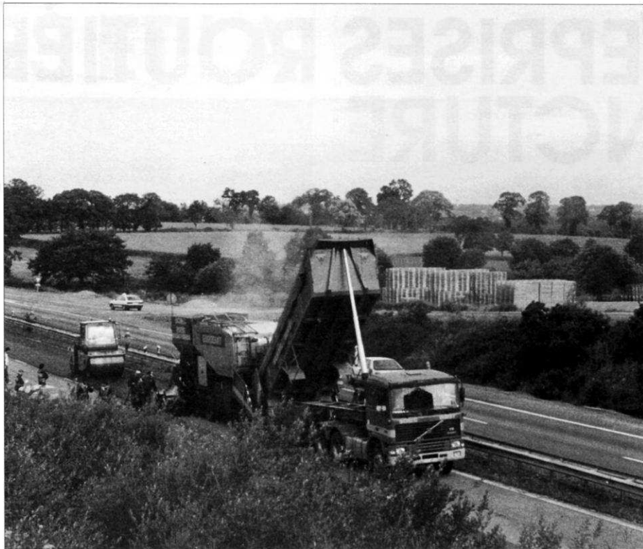
EURODUIT ® : l'enduit sans rejet et sans bruit. Un produit-phare de SCREG Routes : quelque 4 millions de m 2 réalisés. Chantier de la RN 157 (rocade de Rennes).
