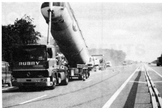
Ravitaillement en liant hydraulique de l'atelier de retraitement (intérêt moyen)
