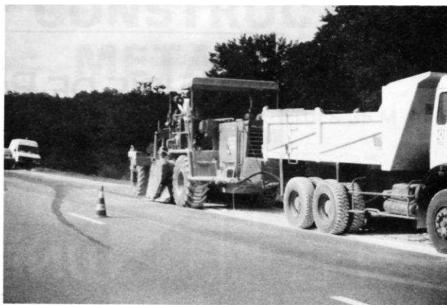
Deuxième étape : l'atelier de traitement de sol en place (intérêt grand)
