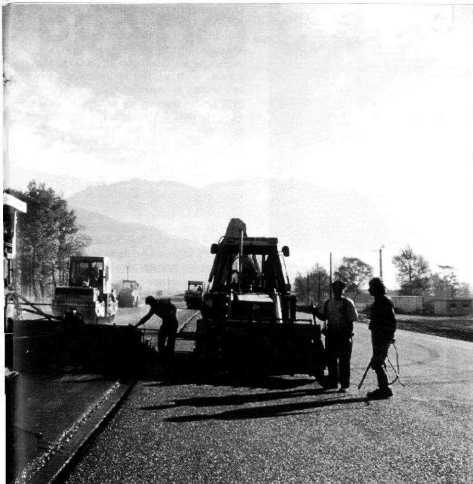
(Autoroute A49 - chantier SACER).
