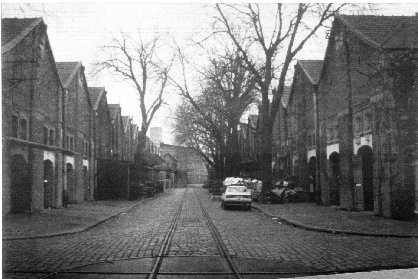
Les entrepôts Lheureux seront réhabilités dans la Z.A.C. Bercy.
