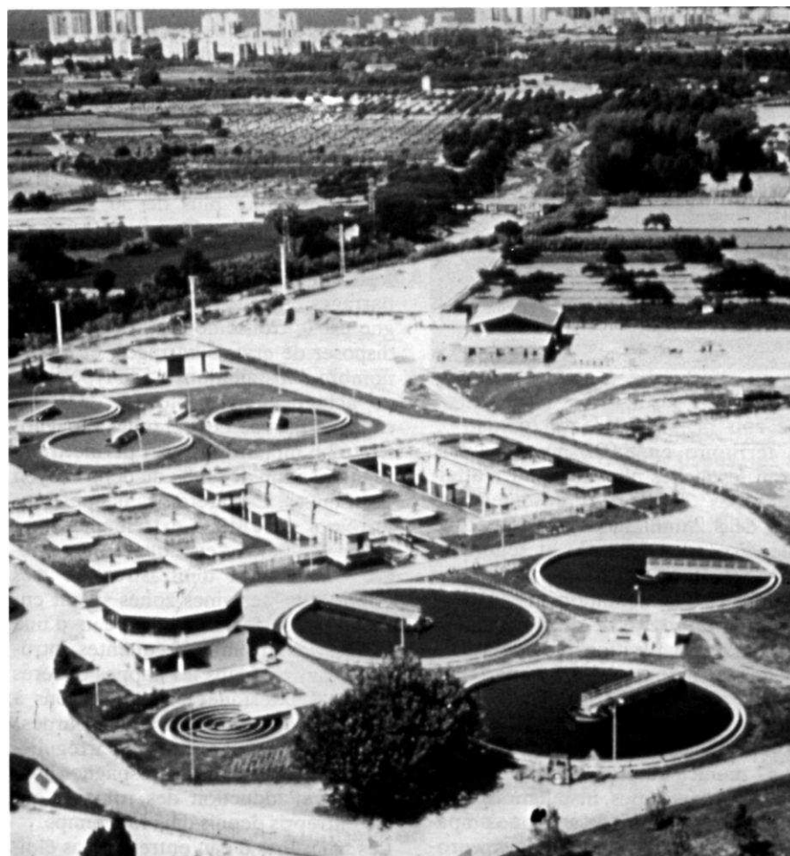
Station d'épuration de Sant Feliu de Guixols (Gerona). Population desservie : 200 000 habitants. Exploitée par ACSA (groupe Agbar) et exploitée par Searsa
