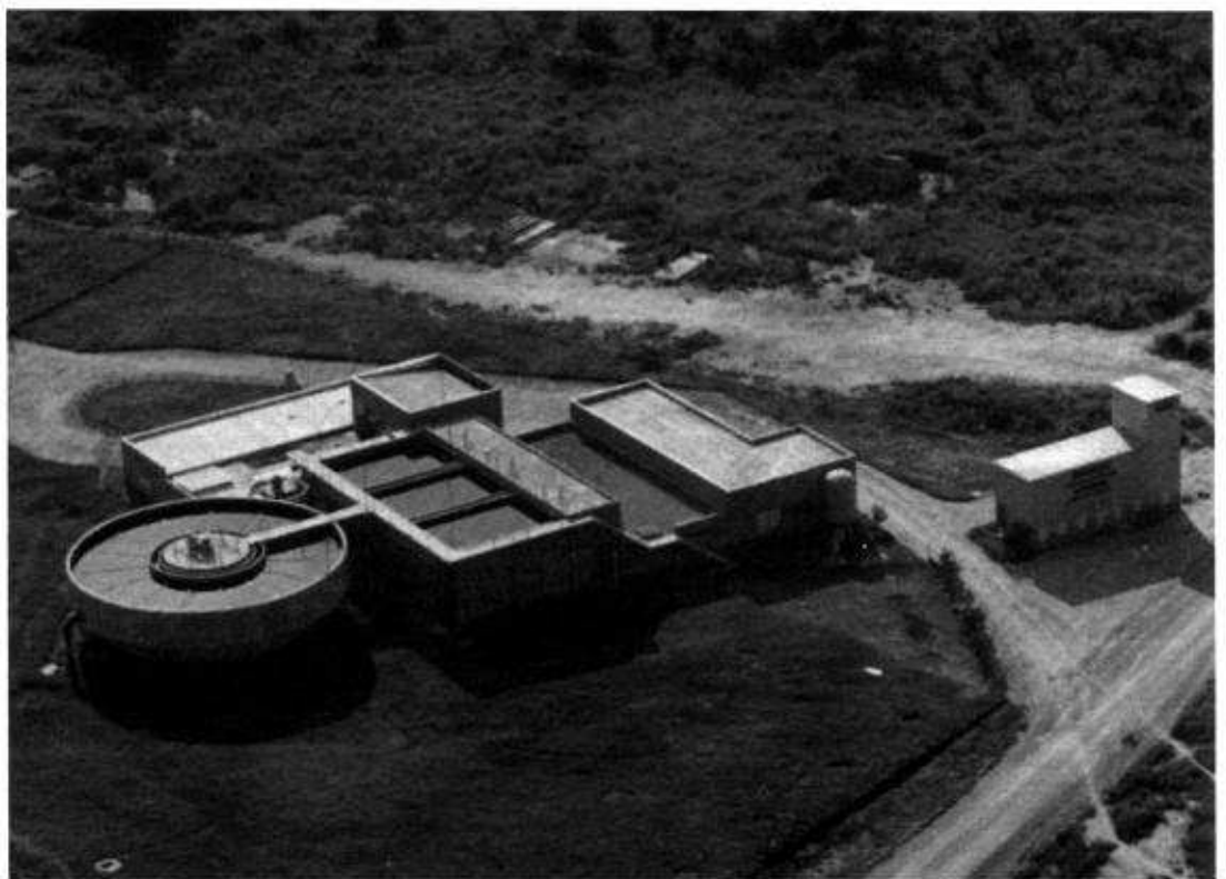
Station de traitement d'eau potable de Bouake (1 500 m 3 /jour).
