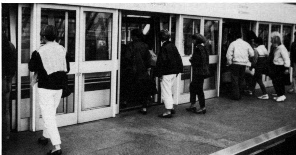
Les Stations et leurs portes palières
