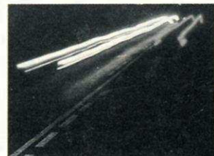
Même marquage de nuit : illustration d'un vieillissement "prématuré".
