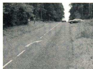
Marquage visible de jour.
