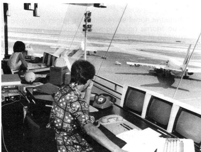
Le Poste de Contrôle de l'Exploitation
