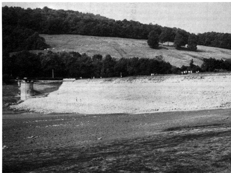
Vue d'amont de la digue en terre de Grosbois-en-Montagne au cours de la vidange de juillet 1983.
