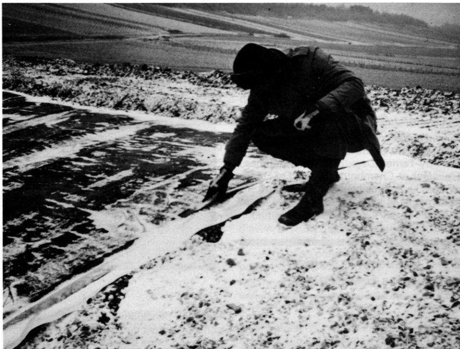
La pose de la géomembrane.
