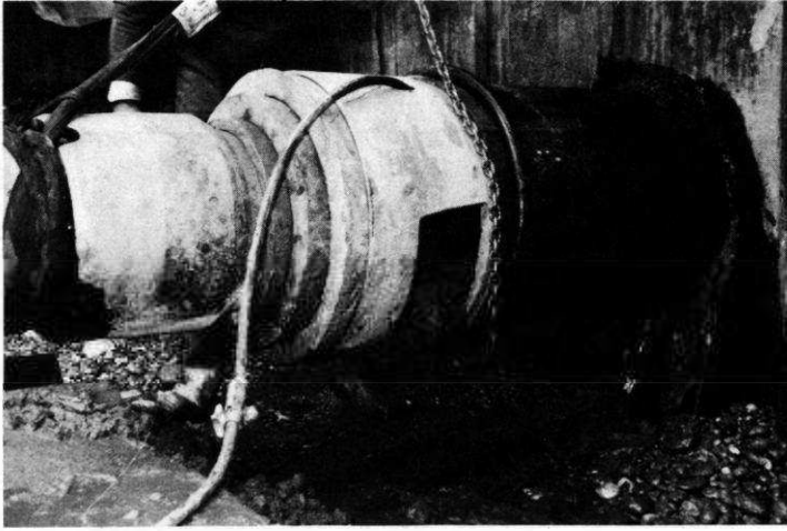
Pièce intermédiaire montée entre le pousse-tube GRUNDORAMM et le tube évitant le compactage du terrain à l'intérieur du tube acier.
