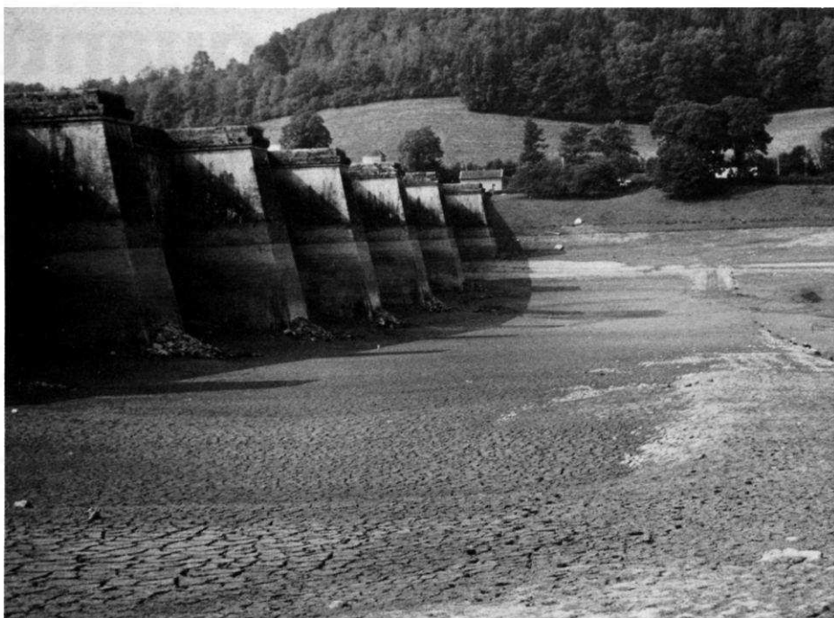
Vue d'aval du mur et des contreforts du barrage de Grosbois-en-Montagne.
