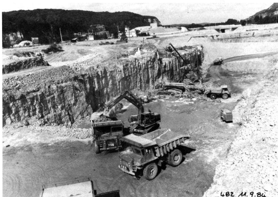
Vue générale des terrassements.
