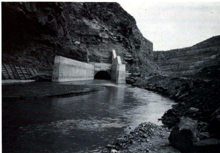
Sortie aval de la dérivation provisoire.
