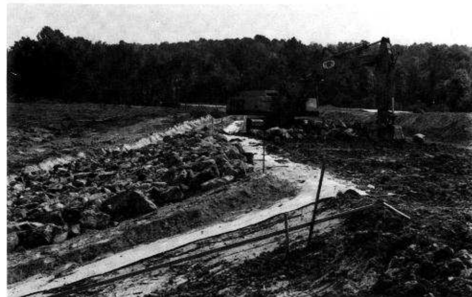
Mise en place du rip rap sur un géotextile.
