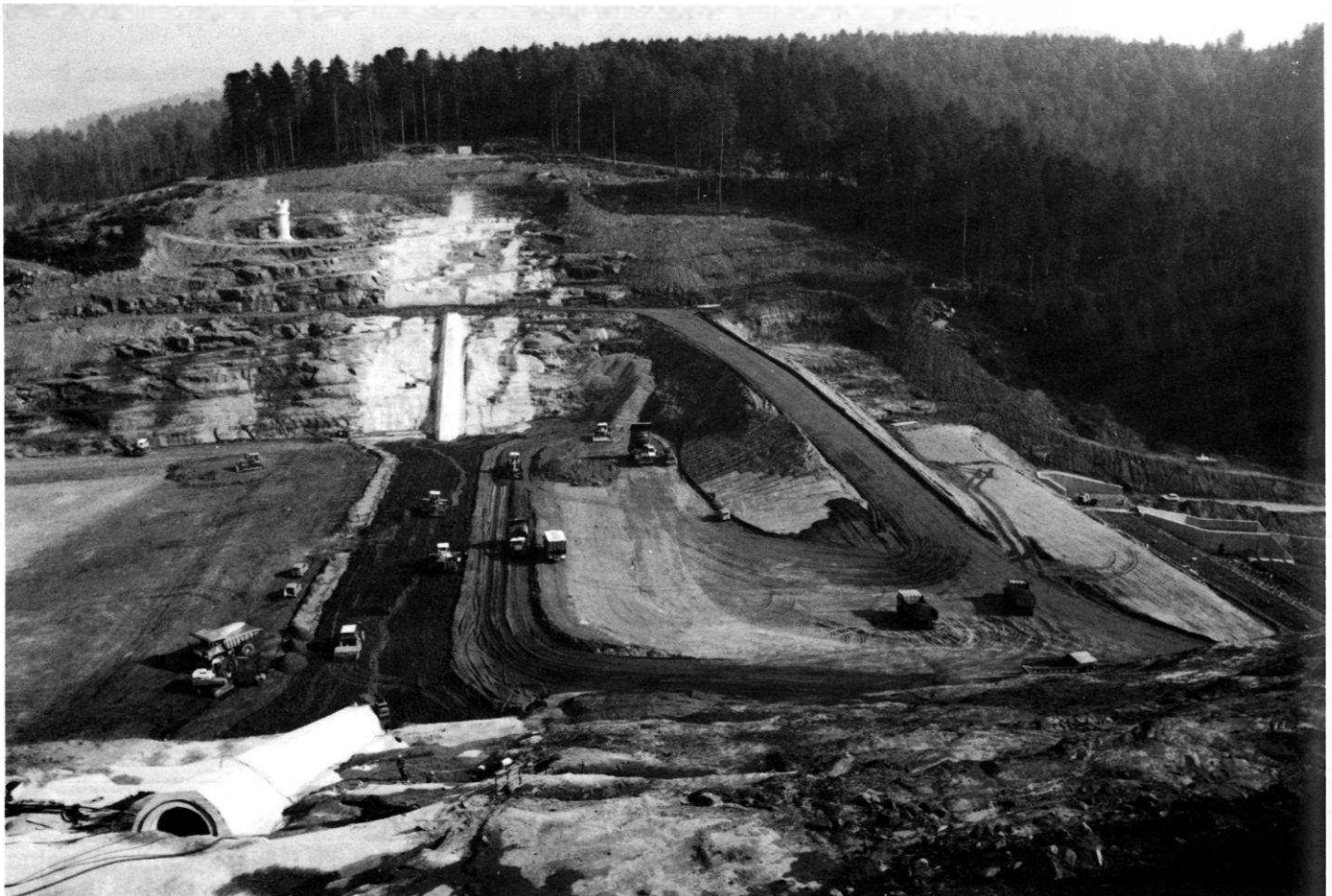
Le barrage en construction.
