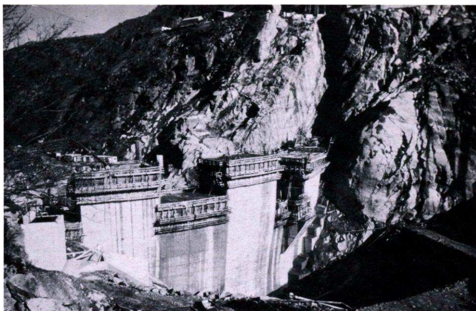
Barrage en construction.
