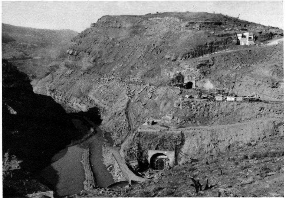
Vue de la vallée depuis l'amont. En rive droite : entrées des galeries de dérivation provisoire et de vidange de fond.
