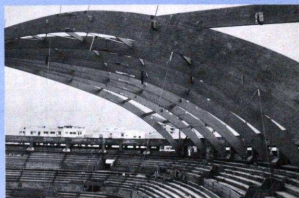
Montage de la piscine Casablanca.
