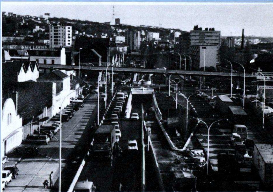
Vue générale du site en travaux.
