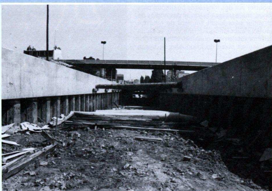
Phase de travaux. Les rideaux sans bâtonnets en attendant le coulage de la dalle en béton.
