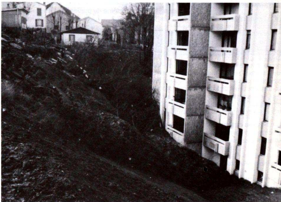
Coulée de boue menaçant le pied d'un immeuble.
