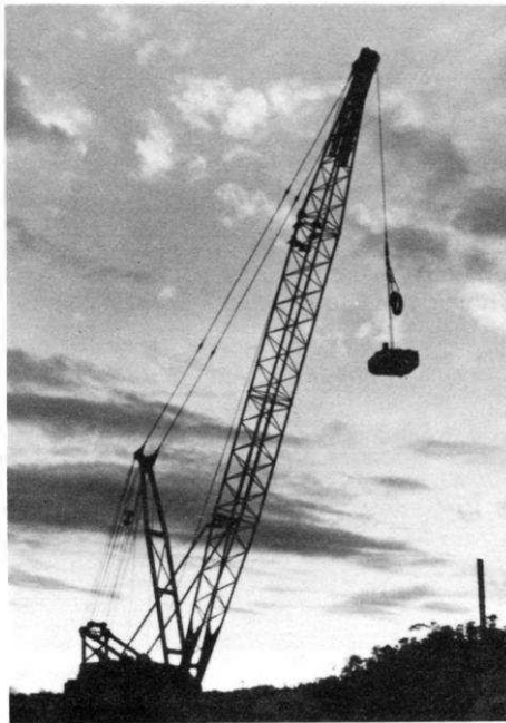
Bintulu : compactage dynamo.
