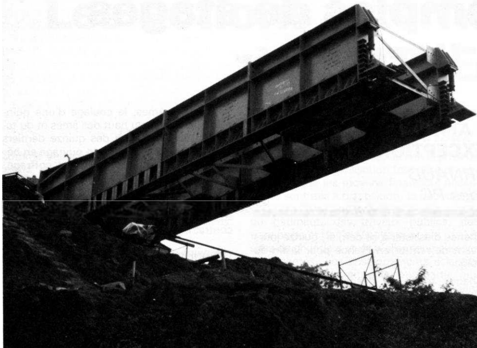
L'Avant bec en cours de poussage.
