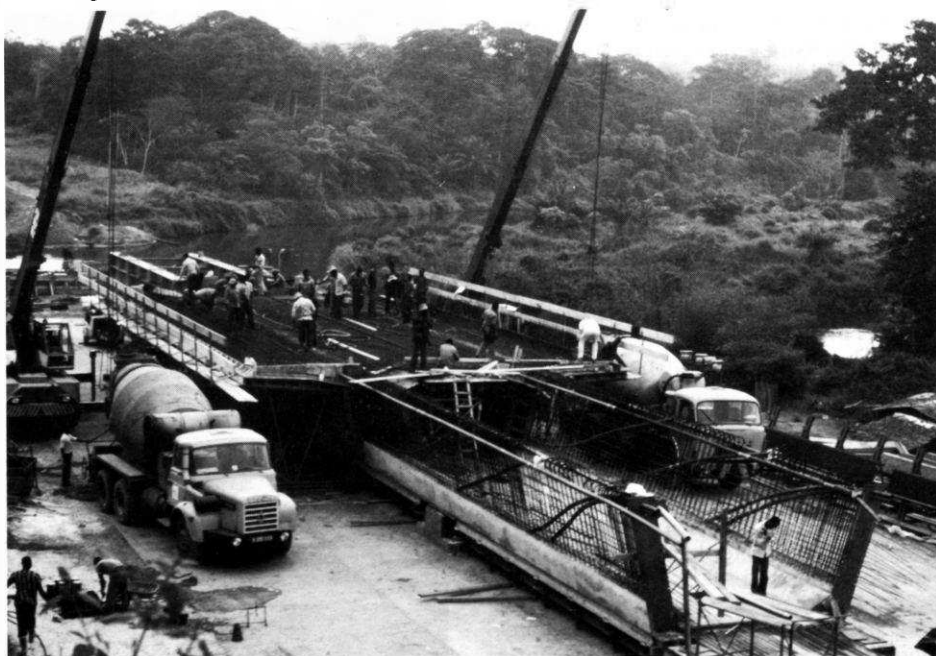
Bétonnage de la 2 e phase de la 1 ère travée.
