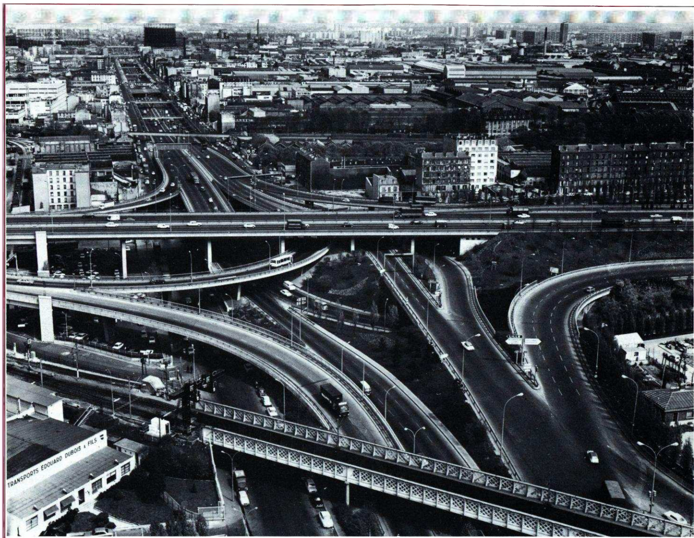
Echangeur Porte de la Chapelle.
